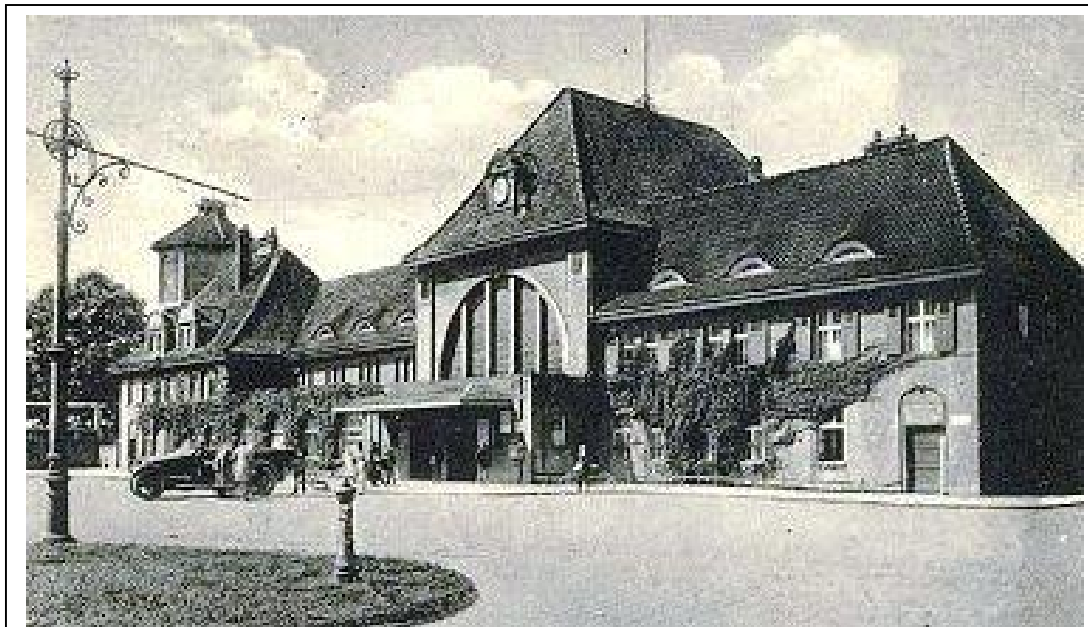
Dworzec kolejowy - I. 30. XX w.
