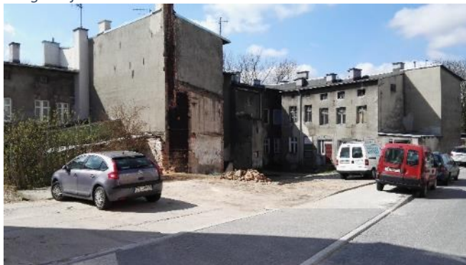
Zdjęcie 25. Niedobór miejsc parkingowych na ul. Podgórznej
