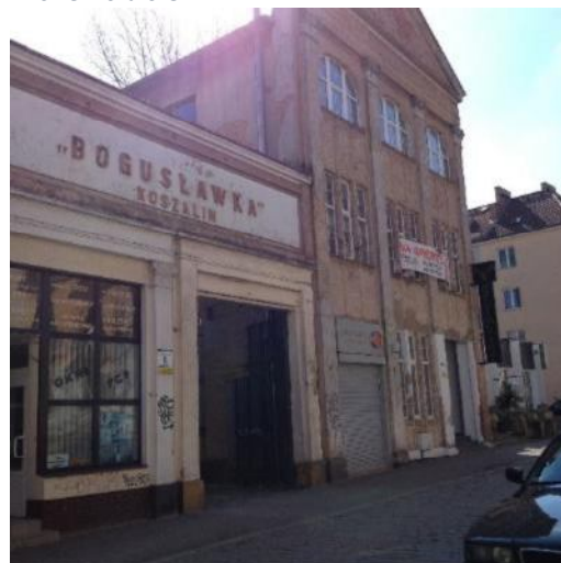
Zdjęcie 28. Wędzarnia (Waldemana) – zakłady („Bogusławka”) – budynki frontowe przy ul. Adama Mickiewicza 6-8.
