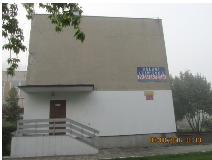
Fot. 7. Elewacja zachodnia (część 2).
