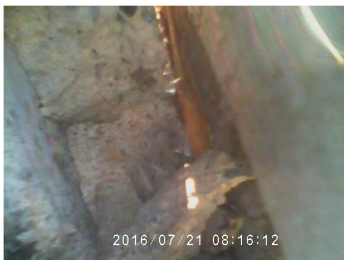
Fot. 24. Pęknięcia w elewacji-brak miejsc lęgowych ptaków i bytowania nietoperzy.
