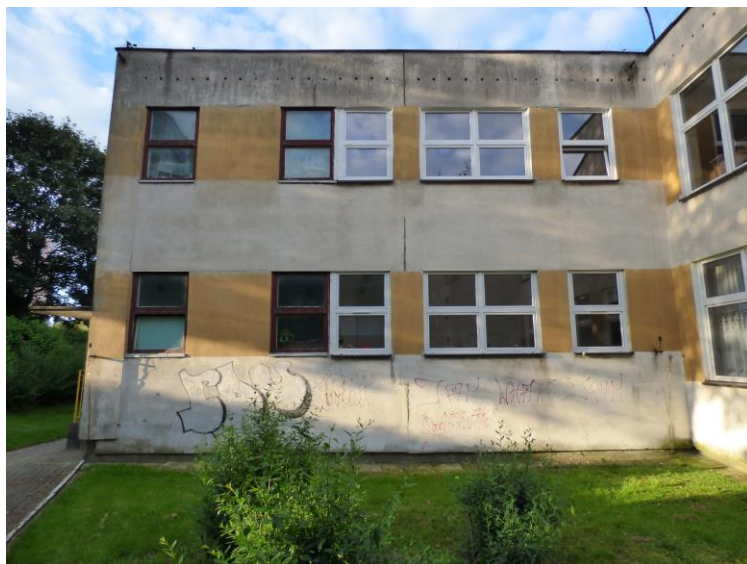
Fot. 2. Elewacja północna (część 2).
