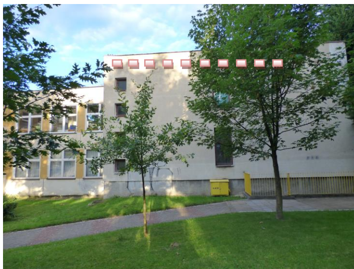
Fot. 27. Lokalizacja 10 skrzynek lęgowych typu A (różowe kwadraty) na elewacji wschodniej.
