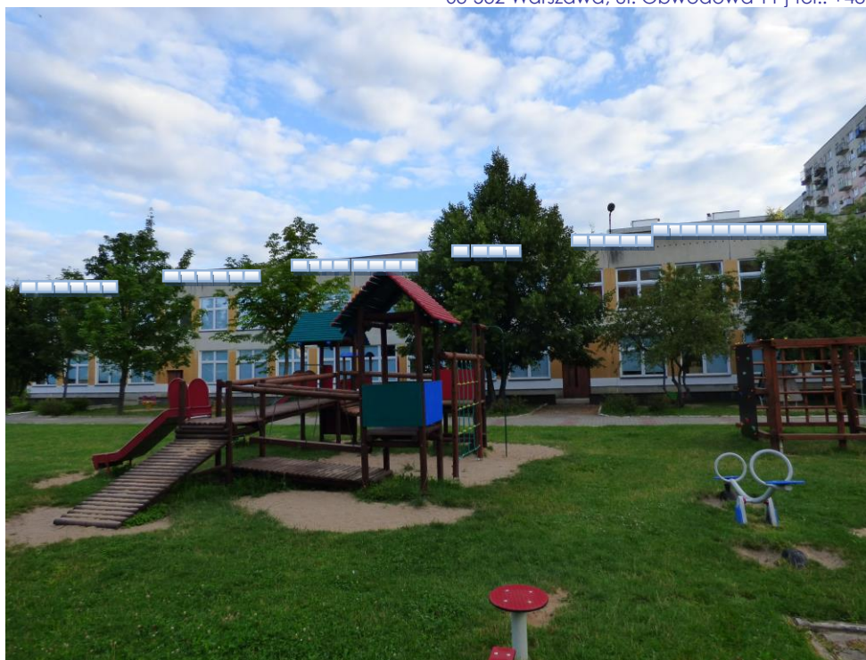
Fot. 26. Lokalizacja 40 skrzynek lęgowych typu J (niebieskie kwadraty) na elewacji południowej.
