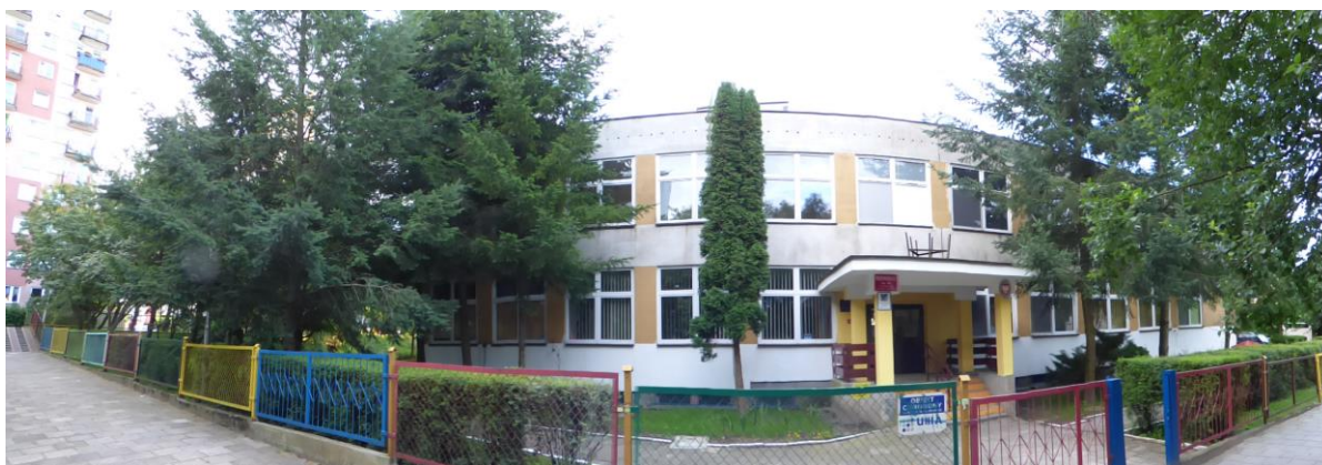
Fot. 1. Główne wejście budynku Przedszkola nr 14 w Koszalinie (elewacja północna) (część 1).
