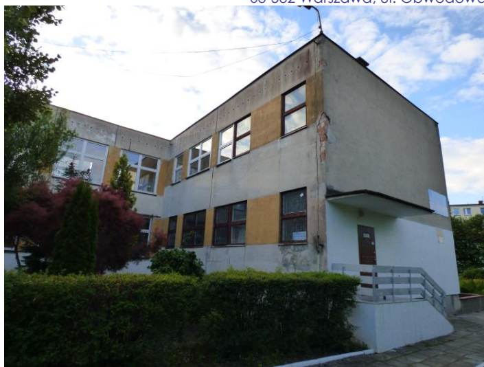
Fot. 3. Elewacja północna (część 3).
