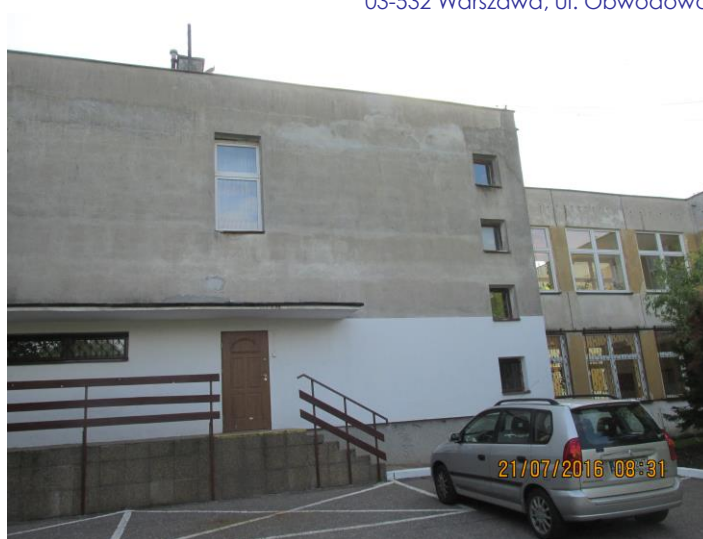
Fot. 6. Elewacja zachodnia (część 1).
