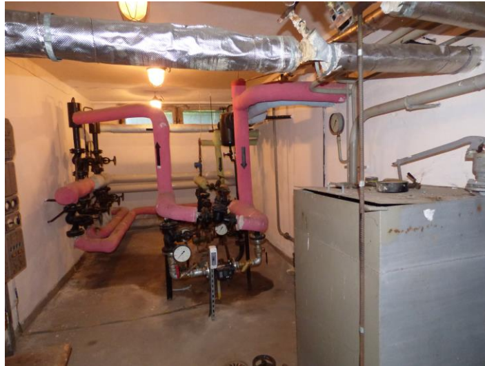
Fot. 25. Piwnica w analizowanym budynku.
