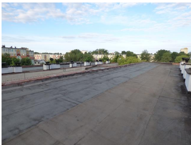
Fot. 21. Dach analizowanego budynku.
