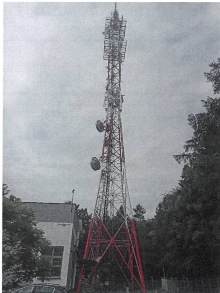
Zdjęcie 1 Badany obiekt
