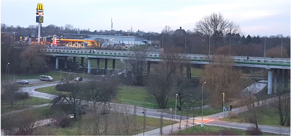
Powyżej: Widok obiektów od strony południowo wschodniej
