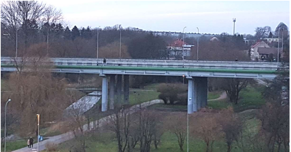
Powyżej: zbliżenie na przęsła 6-7-8
