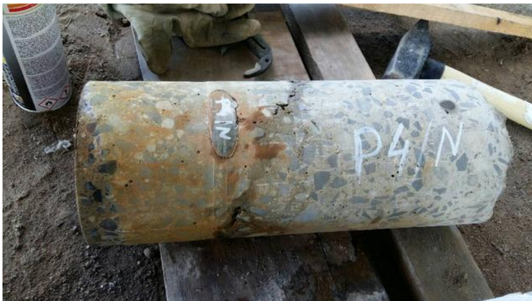
Powyżej: Zasięg korozji wgłębnej.
