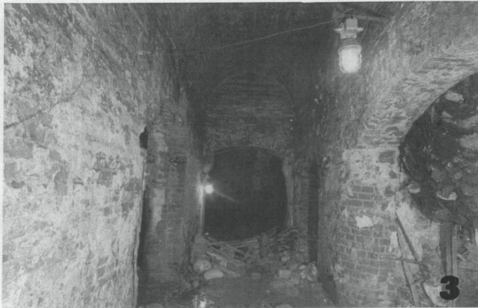
Fot.3. Pomieszczenie nr.3, w głębi pomieszczenie nr4, z prawej strony widoczny zasypany szyb windy.
