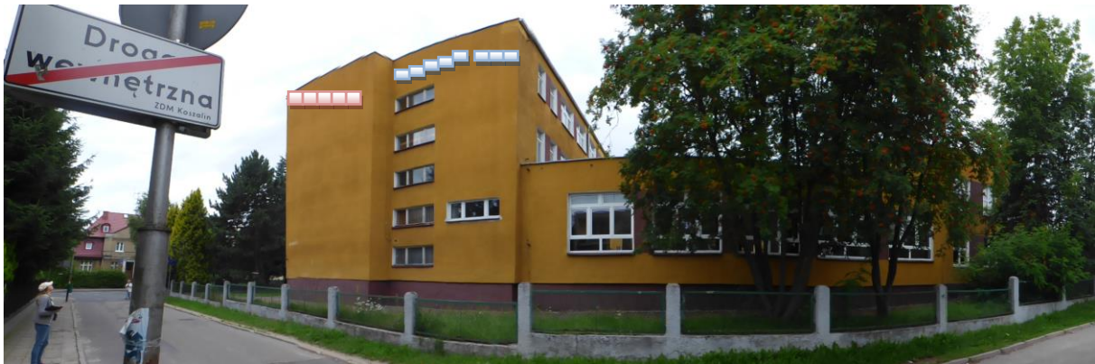
Fot. 30. Lokalizacja skrzynek lęgowych typu A (różowe kwadraty) oraz skrzynek lęgowych typu J (niebieskie kwadraty) na elewacji południowo-wschodniej.
