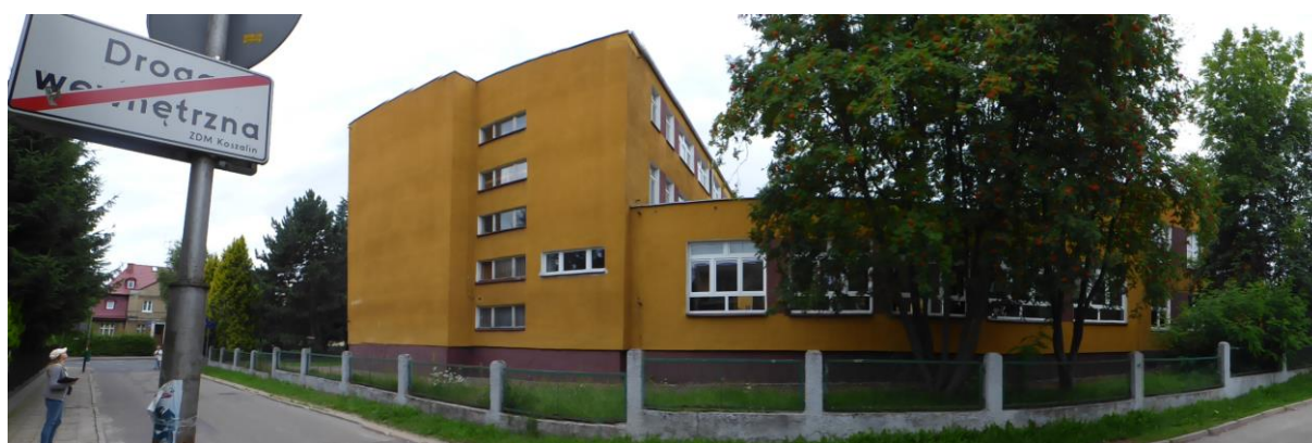
Fot. 5. Elewacja południowo-wschodnia (część 2).
