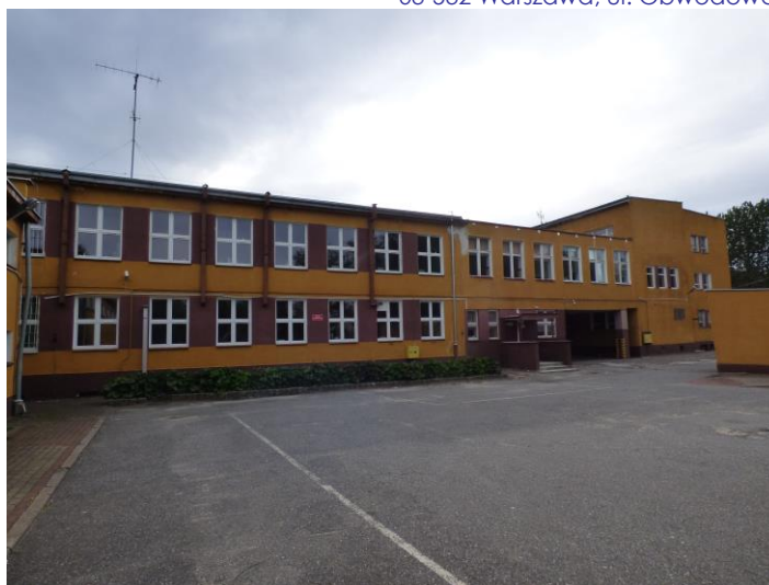
Fot. 9. Elewacja północno-wschodnia (część 1).
