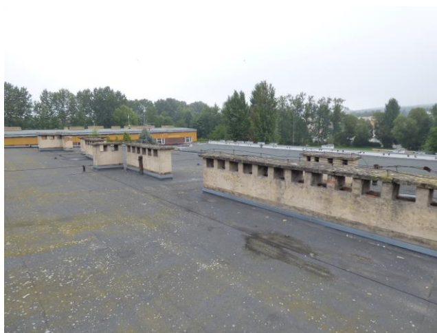
Fot. 26. Dach analizowanego budynku.
