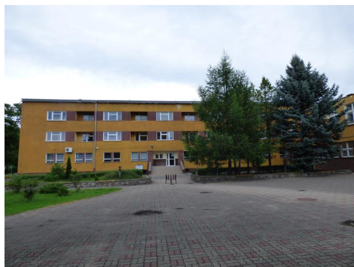
Fot. 4. Elewacja południowo-wschodnia (część 1).
