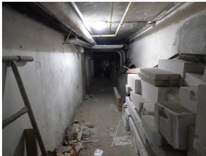
Fot. 29. Piwnica w analizowanym budynku.
