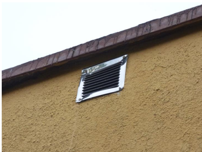
Fot. 13. Zakratowany otwór wentylacyjny.
