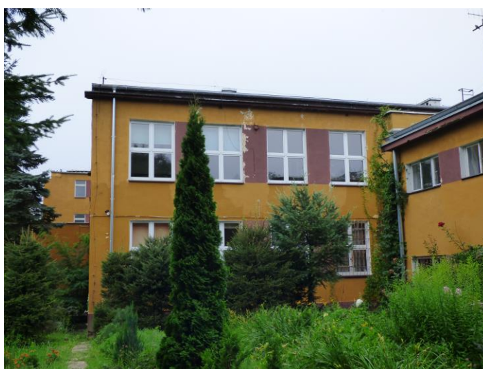
Fot. 11. Elewacja północno-wschodnia (część 3).
