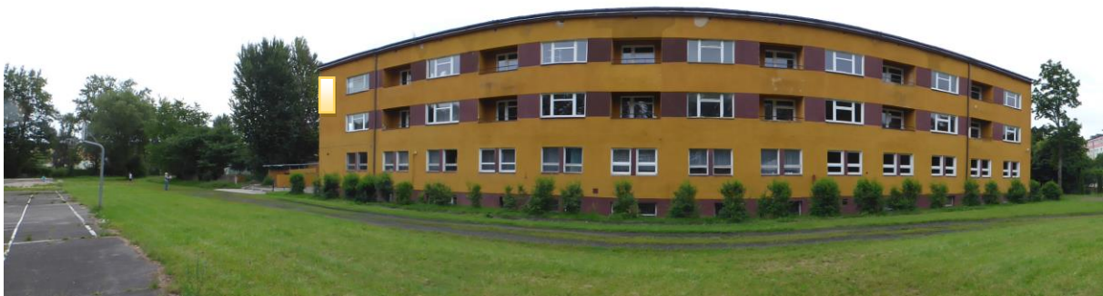
Fot. 31. Lokalizacja skrzyńki lęgowej typu D (pomarańczowy kwadrat) na elewacji północno-zachodniej.
