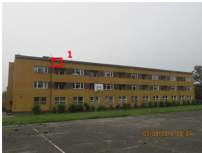
Fot. 14. Elewacja północno-zachodnia (część 1) z zaznaczonymi miejscami lęgowymi (1-kawka).
