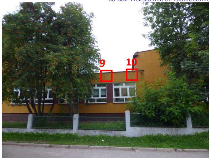
Fot. 22. Elewacja południowo-wschodnia z zaznaczonymi miejscami lęgowymi (9,10-jerzyk)
