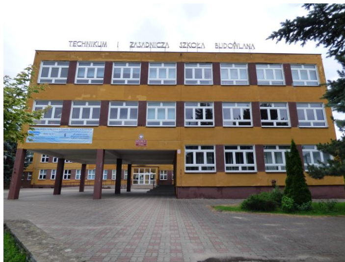
Fot. 1. Elewacja frontowa Zespołu Szkół nr 7 im. Bronisława Bukowskiego w Koszalinie (elewacja południowo-zachodnia) (część 1).
