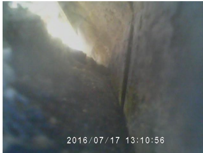
Fot. 28. Ubytki pod parapetami sprawdzone za pomocą endoskopu-brak miejsc lęgowych ptaków i bytowania nietoperzy.
