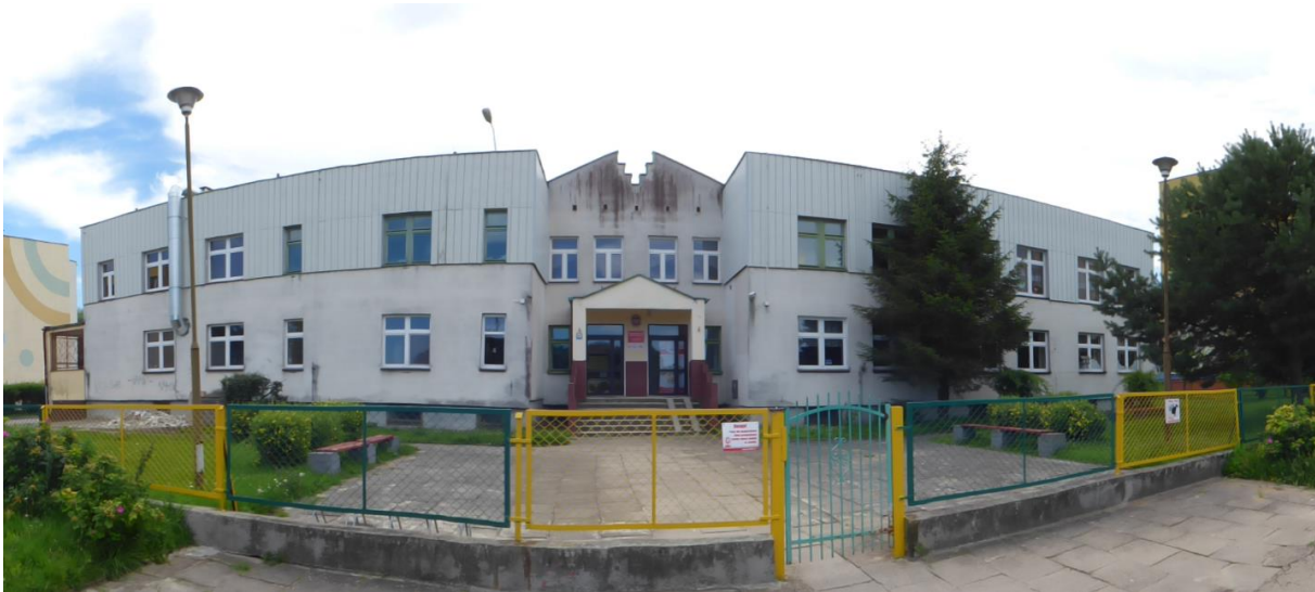
Fot. 1. Główne wejście budynku Przedszkola nr 13 „Mała Akademia” w Koszalinie (elewacja północno-zachodnia).
