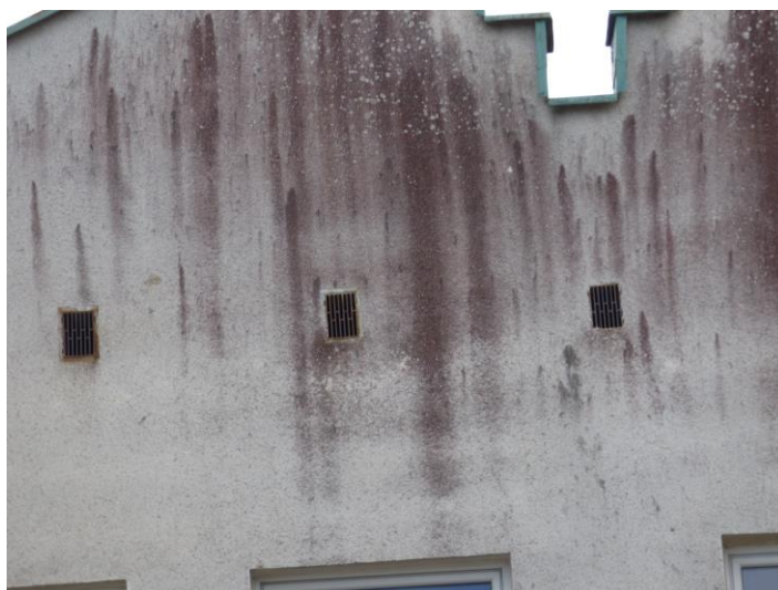
Fot. 5. Zakratowane otwory stropodachu.
