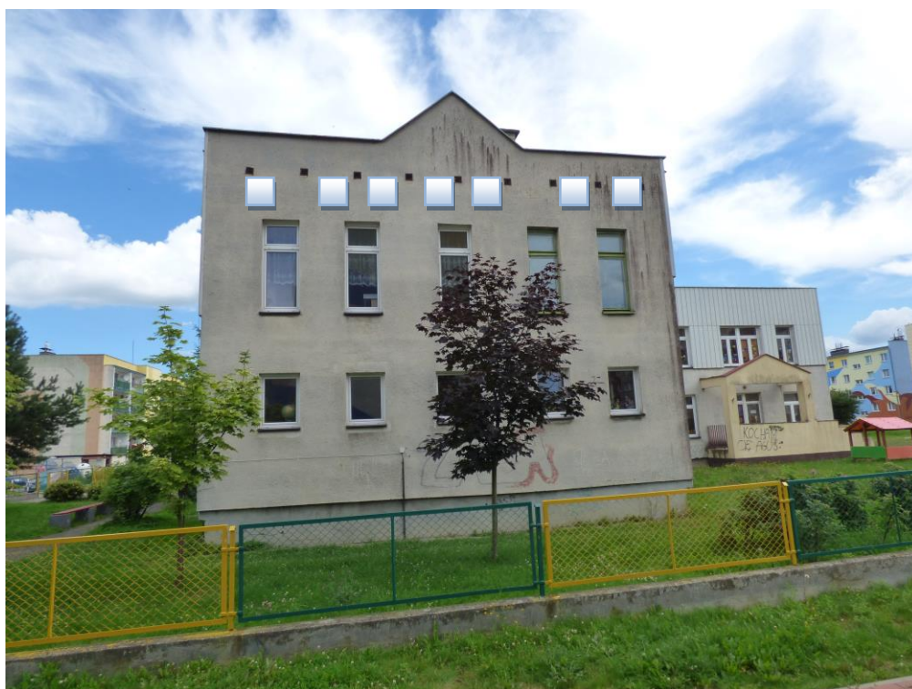
Fot. 24. Lokalizacja 7 skrzynek łęgowych typu J (niebieskie kwadraty) na elewacji południowo-zachodniej.
