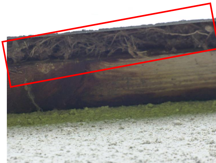
Fot. 11. Gniazdo wróbla pod blachą ścienną (kwadrat nr 6).
