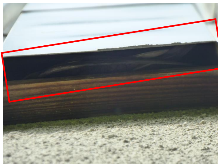
Fot. 14. Widoczny jerzyk w gnieździe pod blachą ścienną (kwadrat nr 12).
