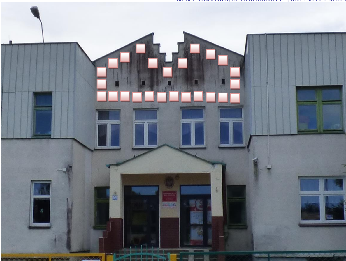
Fot. 23. Lokalizacja 25 skrzynek łęgowych typu A (różowe kwadraty) na elewacji północno-zachodniej.
