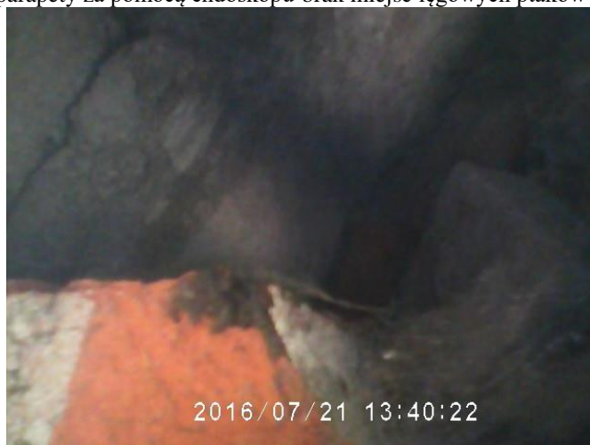
Fot. 21. Ubytki w elewacji sprawdzone za pomocą endoskopu -brak miejsc lęgowych ptaków i bytowania nietoperzy.
