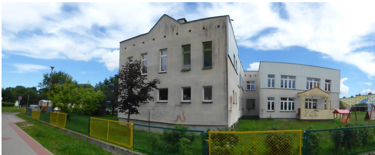
Fot. 2. Elewacja południowo-zachodnia.
