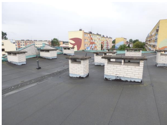
Fot. 19. Dach analizowanego budynku.
