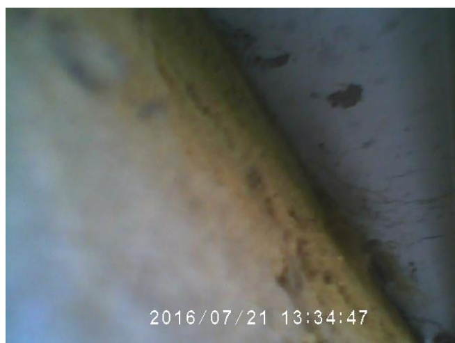
Fot. 20. Sprawdzone parapety za pomocą endoskopu-brak miejsc lęgowych ptaków i bytowania nietoperzy.
