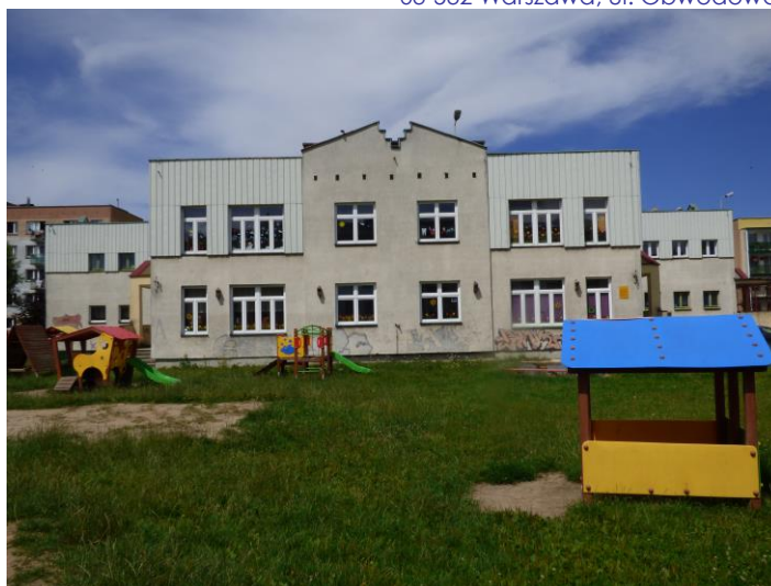
Fot. 3. Elewacja południowo-wschodnia.
