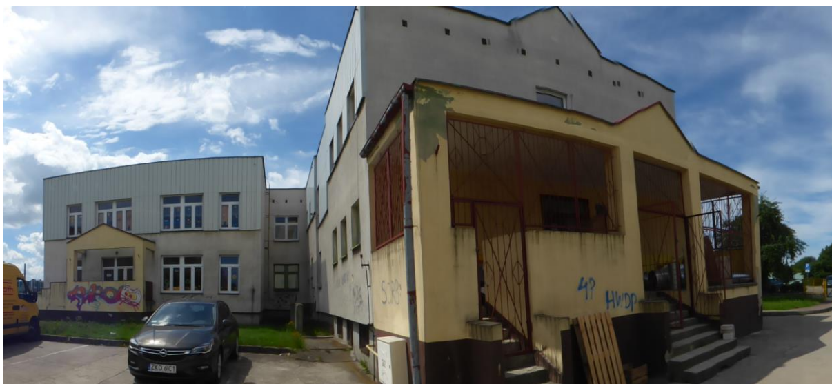
Fot. 4. Elewacja północno-wschodnia.
