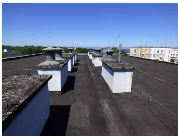
Fot. 15. Dach analizowanego budynku.
