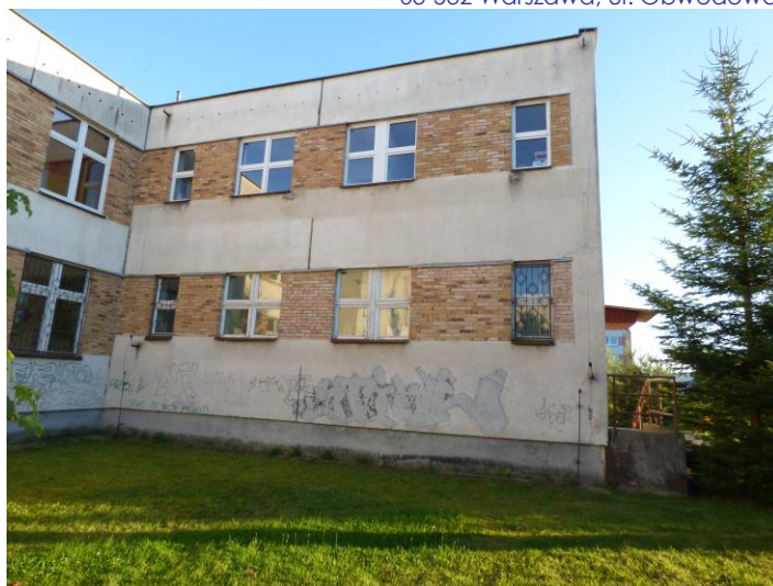
Fot. 3. Elewacja północno-wschodnia (część 3).
