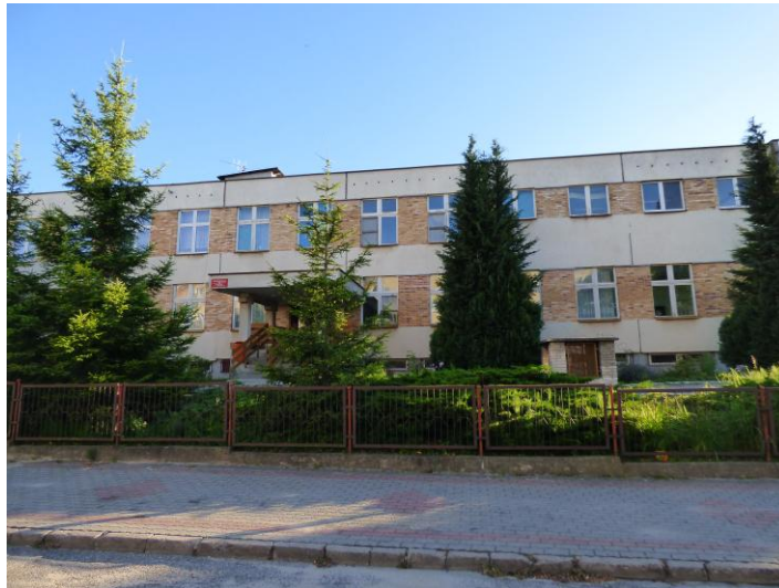
Fot. 1. Główne wejście budynku Przedszkola nr 15 w Koszalinie (elewacja północno-wschodnia) (część 1).
