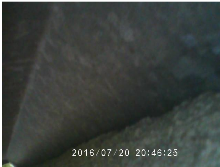
Fot. 16. Elewacja pod parapetami sprawdzona za pomocą endoskopu-brak miejsc lęgowych ptaków i bytowania nietoperzy.
