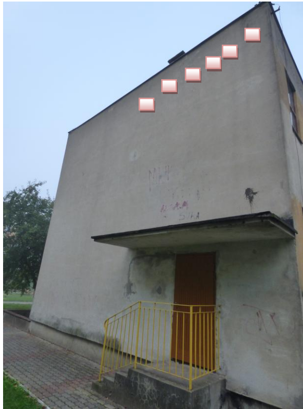
Fot. 19. Lokalizacja 6 skrzynek lęgowych typu A (różowe kwadraty) na elewacji południowo-wschodniej.
