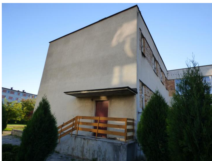
Fot. 5. Elewacja południowo-wschodnia (część 2).
