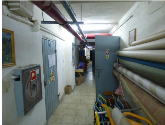
Fot. 18. Piwnica w analizowanym budynku.
