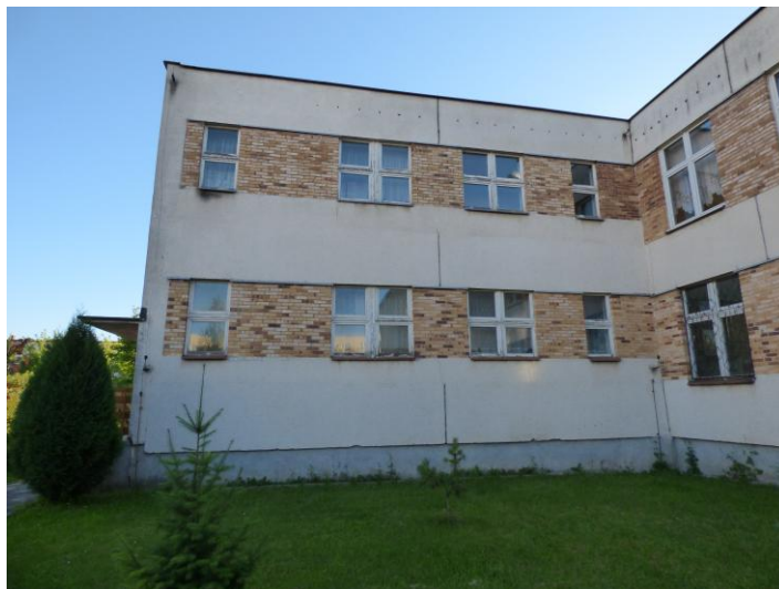
Fot. 2. Elewacja północno-wschodnia (część 2).
