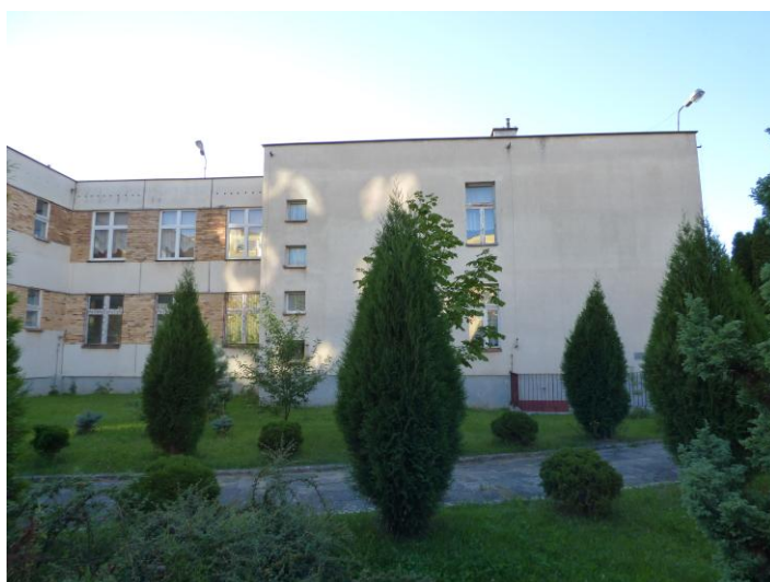
Fot. 4. Elewacja południowo-wschodnia (część 1).
