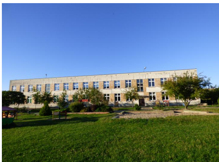
Fot. 8. Elewacja południowo-zachodnia.
