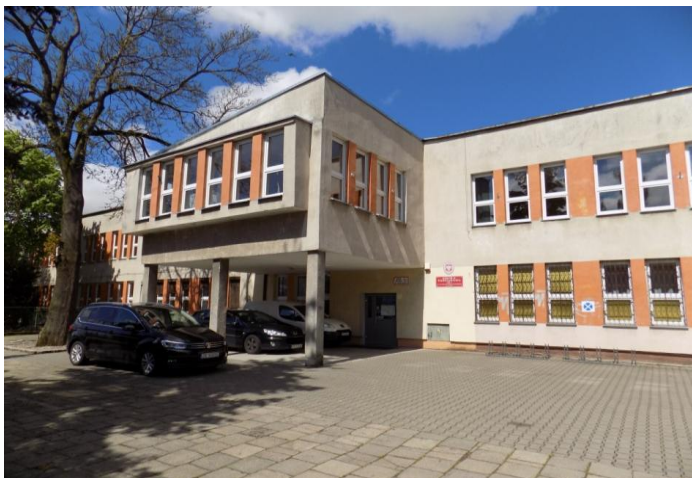
A - BUDYNEK GŁÓWNY
