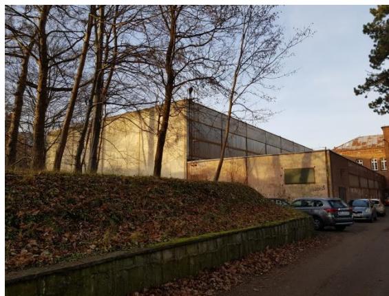
Fot. 2 Widok budynku hali sportowej od strony południowej, duża powierzchnia przeszklenia panelami typu VITROLIT.
