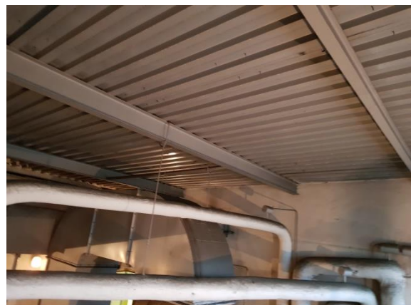
Fot. 8 Wnętrze maszyny w wentylacyjnej, widok na stalową konstrukcję dachu. Przekroje nośne w bardzo dobrym stanie technicznym, nie wykazują odkształceń. Poszycie dachu szczelne.
