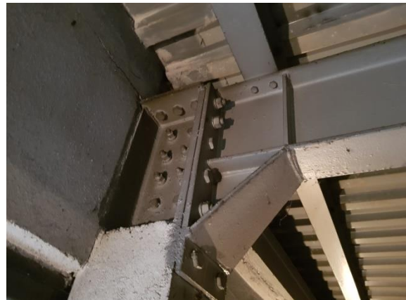
Fot. 6 Węzeł połączenia słupa z podciągami stalowej konstrukcji zaplecza hali sportowej (niska część). Elementy połączeniowe i węzeł nie wykazują odkształceń, przemieszczeń lub korozji.
