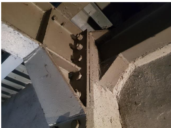
Fot. 7 Widok węzła konstrukcyjnego (patrz fot.6) ze strony przeciwnej. Brak oznak nieprawidłowości wywołanych eksploatacją budynku.
