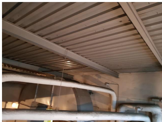
Fot. 8 Wnętrze maszynowni wentylacyjnej, widok na stalową konstrukcję dachu. Przekroje nośne w bardzo dobrym stanie technicznym, nie wykazują odkształceń. Poszycie dachu szczelne.
