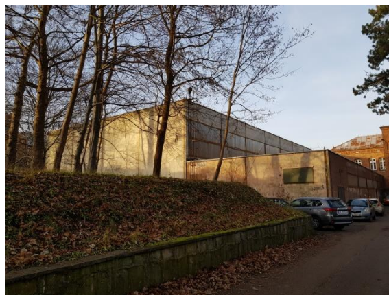
Fot. 2 Widok budynku hali sportowej od strony południowej, duża powierzchnia przeszklona panelami typu VITROLIT.
