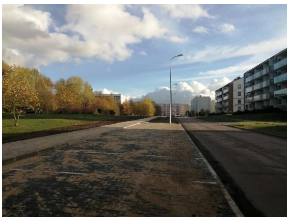
Budowa dziesięciu miejsc parkingowych wzdłuż ulicy Doroszewskiego
