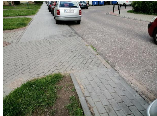
Modernizacja chodnika przy budynku ul. Kostenckiego 2-4d w Koszalinie o pow. 260m 2
