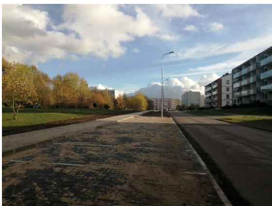
Budowa dziesięciu miejsc parkingowych wzdłuż ulicy Doroszewskiego
