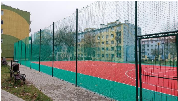
Kontynuacja przebudowy boiska asfaltowego na teren rekreacyjno – zabawowo – sportowy przy ul. Emilii Gierczak – 2. etap budowy boiska wielofunkcyjnego.
