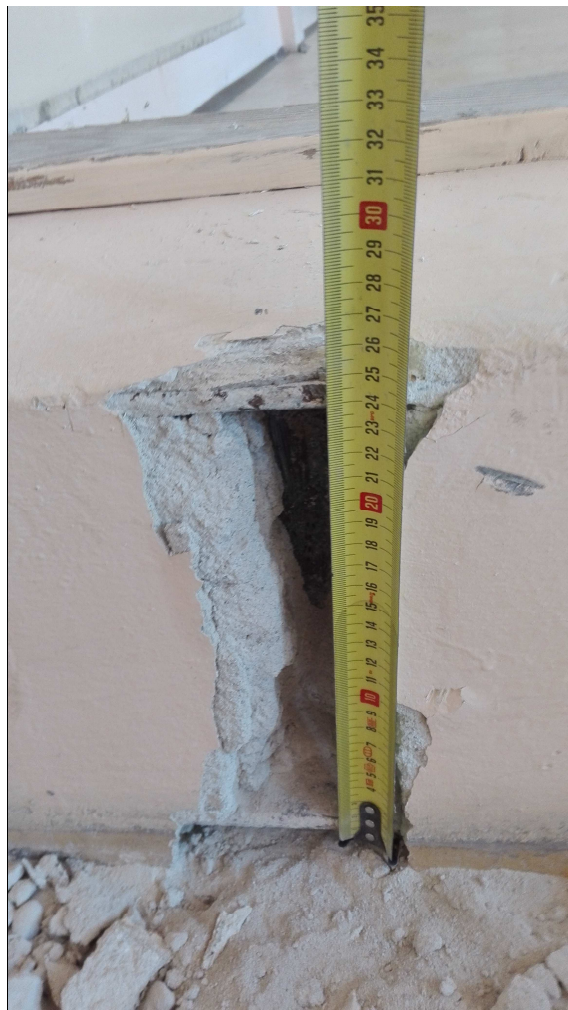
Ściana murowana nad stropem I piętra posadowiona na 2 I 240 do wyburzenia.
