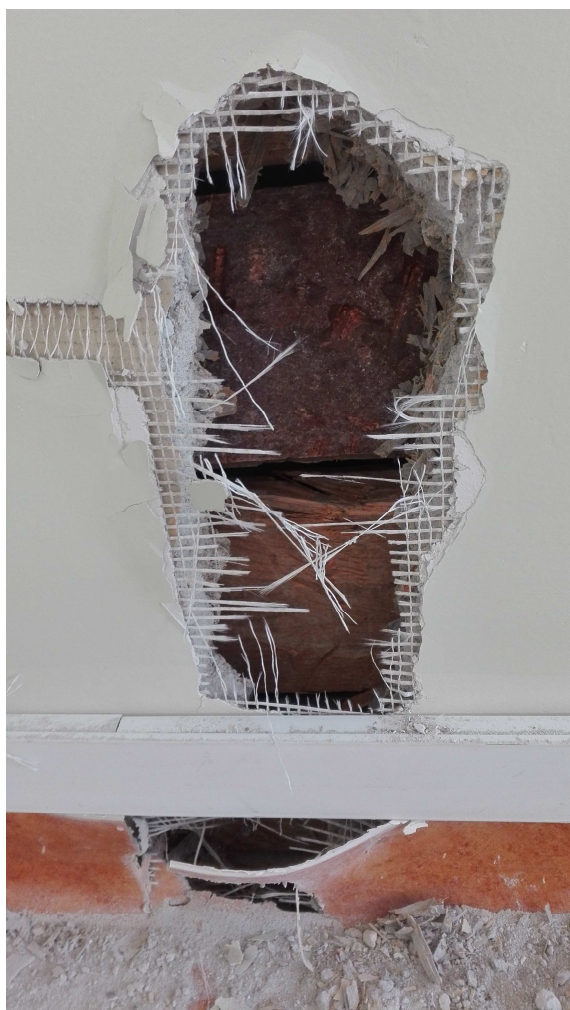
Ściana drewniana I piętra na ruszcie drewnianym do demontażu.
