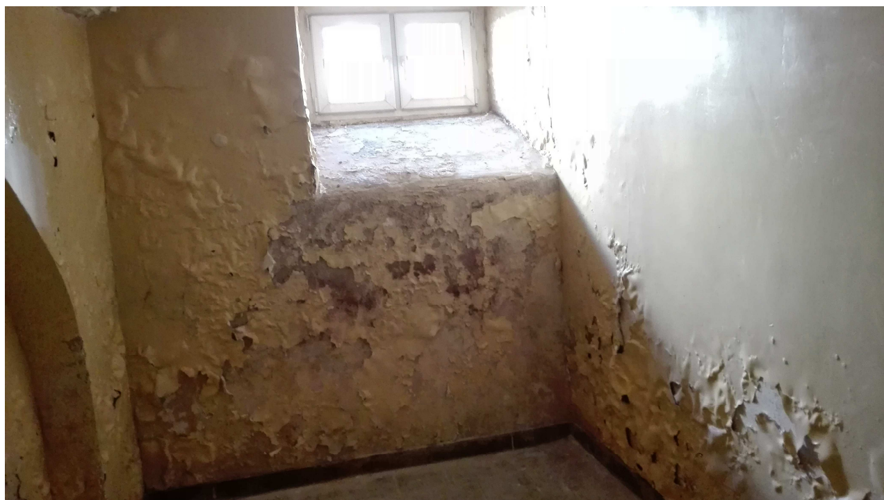
Działanie wilgoci powoduje znaczne ubytki korozyjne ścian.
