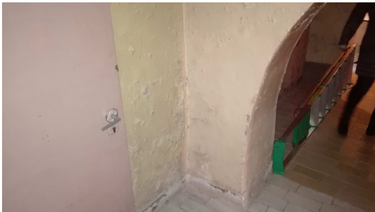
Działanie wilgoci powoduje znaczne ubytki korozyjne ścian.
