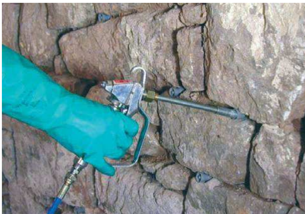
Rozmieszczenie pakerów w murze.
