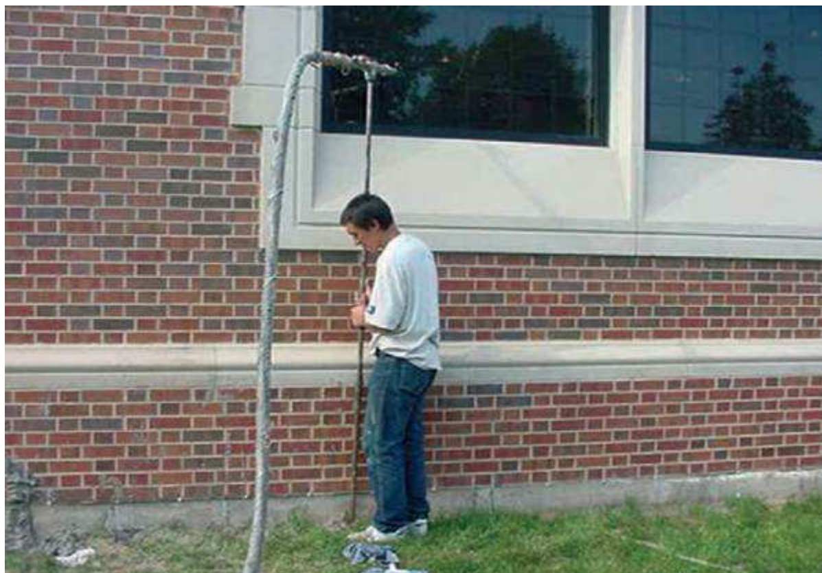
Wykonywanie iniekcji kurtynowej w grunt zawiesinami bentonitowymi.
