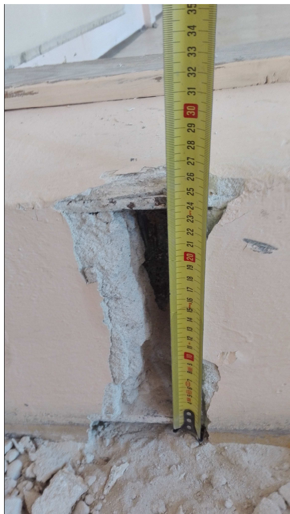
Ściana murowana nad stropem I piętra posadowiona na 2 I 240 do wyburzenia.
