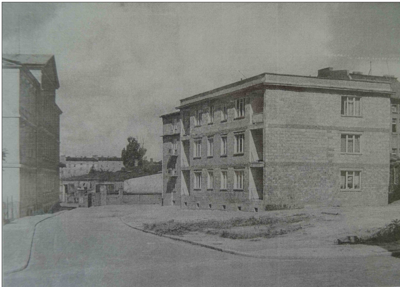
fot. 5. Fragment ulicy Krzywoustego , po lewej widoczny budynek szkoły, 1959 rok.
