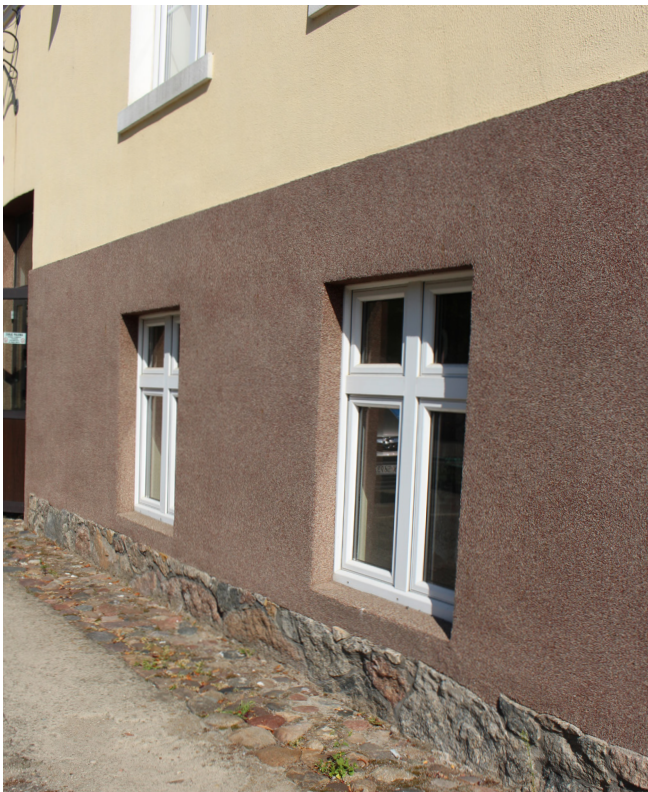
fot. 54, 55 W 2011 roku wykonano remont elewacji oraz wymieniono na nowy system odprowadzenia wód opadowych. Na wysokość dwóch metrów od gruntu wykonano tynki epoksydowe, uszczelniające i izolujące wodę z rozbrzygów odbijającą się od opasek lub terenu. Usunięto większość zagrożeń wynikających z przenikania wód opadowych, jednak nie wykonano izolacji pionowej i poziomej budynku, przez co nie powstrzymano wody podciąganej kapilarnie do ścian piwnic, stan 2020 rok, fot. M.Caban
