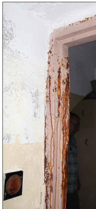
fot. 35, 36. Widoczne, wykwity solne, łuszczące się farby oraz skażenie mikrobiologiczne, metalowa futryna całkowicie zardzewiała od panującej w pomieszczeniu wilgoci, stan 2020 rok. fot. M. Caban
