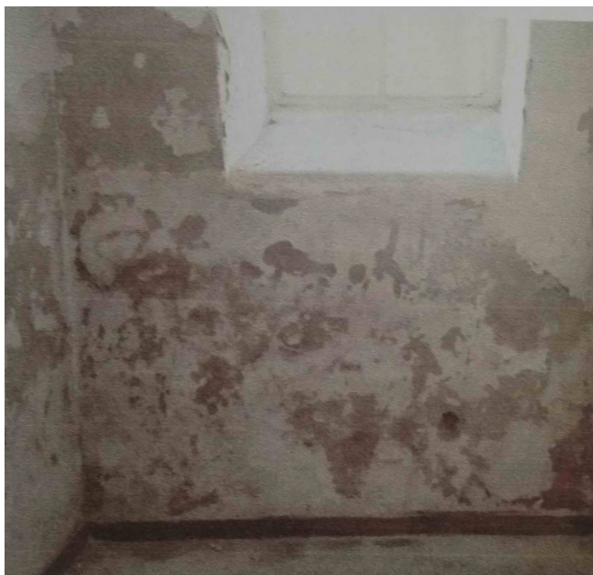
fot. 56. Ściana od ulicy Krzywoustego stan 2009 rok. „OPINIA TECHNICZNA IZOLACJA POZIOMA I PIONOWA ŚCIAN PIWNIC”, mgr inż, Andrzej Kierzek, Koszalin, sierpień 2009
