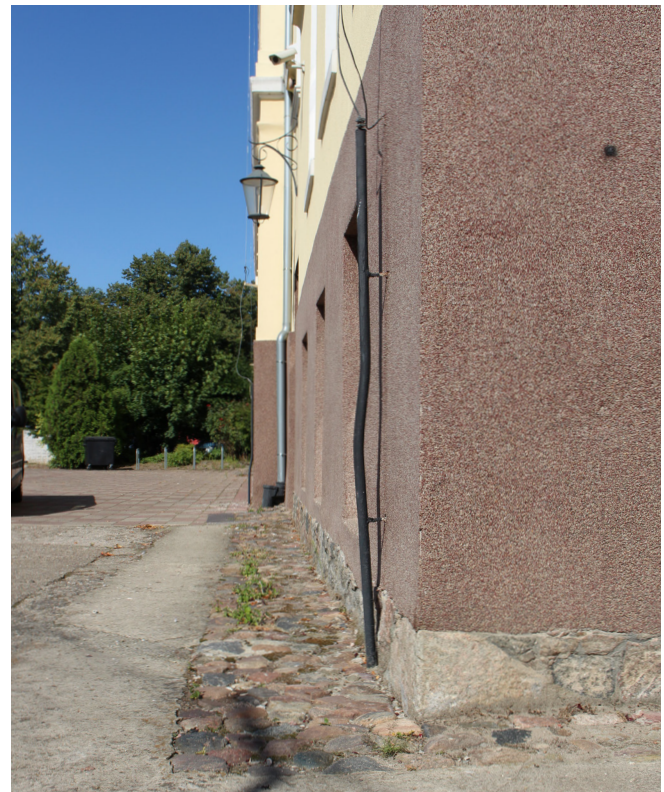
fot. 54, 55 W 2011 roku wykonano remont elewacji oraz wymieniono na nowy system odprowadzenia wód opadowych. Na wysokość dwóch metrów od gruntu wykonano tynki epoksydowe, uszczelniające i izolujące wodę z rozbrzygów odbijającą się od opasek lub terenu. Usunięto większość zagrożeń wynikających z przenikania wód opadowych, jednak nie wykonano izolacji pionowej i poziomej budynku, przez co nie powstrzymano wody podciąganej kapilarnie do ścian piwnic, stan 2020 rok, fot. M.Caban
