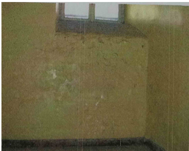
fot. 56. Ściana od ulicy Krzywoustego stan 2009 rok. „OPINIA TECHNICZNA IZOLACJA POZIOMA I PIONOWA ŚCIAN PIWNIC”, mgr inż, Andrzej Kierzek, Koszalin, sierpień 2009
