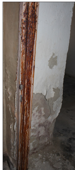
fot. 35, 36. Widoczne, wykwity solne, łuszczące się farby oraz skażenie mikrobiologiczne, metalowa futryna całkowicie zardzewiała od panującej w pomieszczeniu wilgoci, stan 2020 rok. fot. M. Caban
