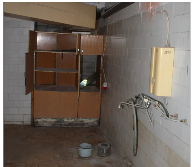
fot. 20. Zmywalnia - stan 2020 rok. fot. M. Caban
