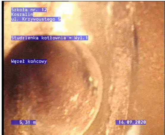
Zdjęcie: 2_1_2_29092020_142915_A.jpg, 00:01:08 5,31m, Wężel końcowy Wyl.1
