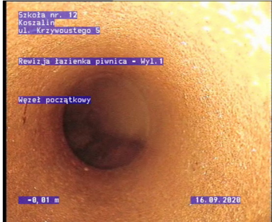
Zdj cie: 8_1_1_29092020_145959_A.jpg, 00:00:01 0m, W zeł pocz tkowy Rewizja łazienka piwnica
