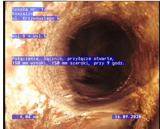
Zdjęcie: 6_1_4_29092020_145407_B.jpg, 00:01:25 6,04m, Poł czenie, ł cznik, przył cze otwarte, 150 mm wysoki, 150 mm szeroki, przy 9 godz.
