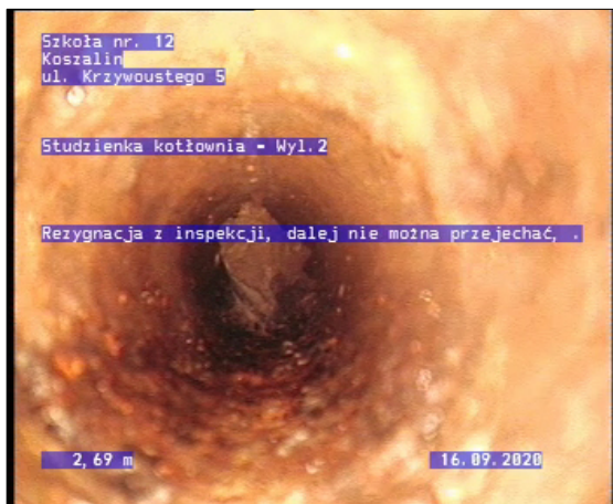
Zdjęcie: 3_1_5_29092020_143203_A.jpg, 00:01:38 2,69m, Rezygnacja z inspekcji, dalej nie można przejechać, . / .
