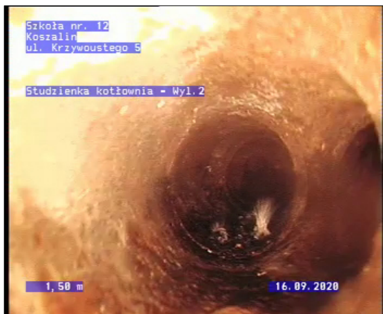
Zdjęcie: 3_1_3_29092020_143046_A.jpg, 00:00:44 1,81m, Poł czenie, ł cznik, przył cze otwarte, 100 mm wysoki, 100 mm szeroki, przy 9 godz.
