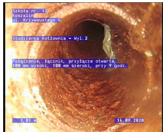
Zdjęcie: 3_1_3_29092020_143056_B.jpg, 00:00:44 1,81m, Poł czenie, ł cznik, przył cze otwarte, 100 mm wysoki, 100 mm szeroki, przy 9 godz.
