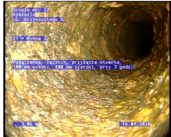
Zdjęcie: 4_1_2_29092020_135119_B.jpg, 00:00:27 3,05m, Poł czenie, ł cznik, przył cze otwarte, 100 mm wysoki, 100 mm szeroki, przy 3 godz.
