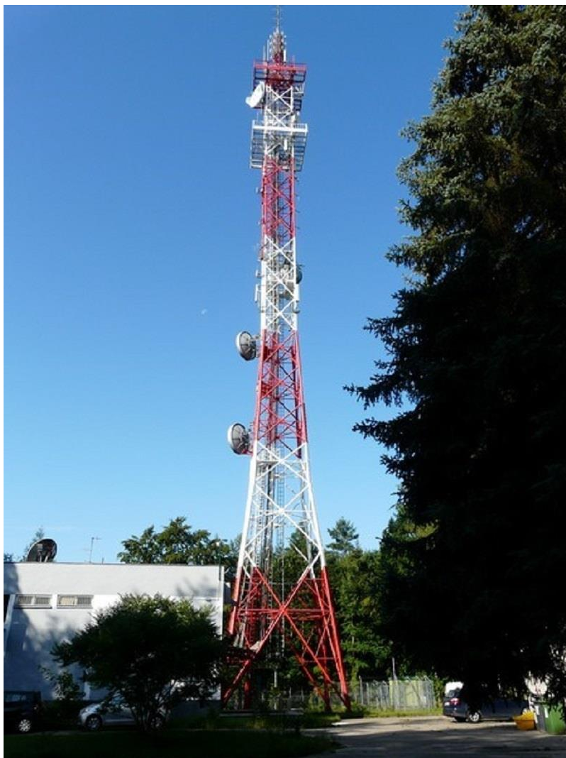
Fot. 1. RTON Koszalin / Góra Chelmska – widok obiektu
