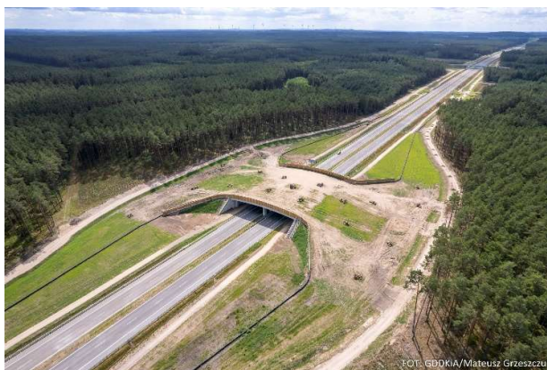
S11 – Przejście dla zwierząt na odcinku Zegrze Pomorskie – Kłanino, wrzesień 2023 r. Źródło: GDDKiA O. Szczecin
