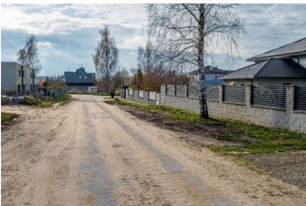
Wykonanie nawierzchni na ulicy Oliwkowej i Migdałowej
