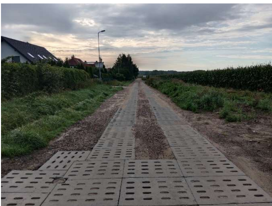
Modernizacja nawierzchni ulica Goździków
