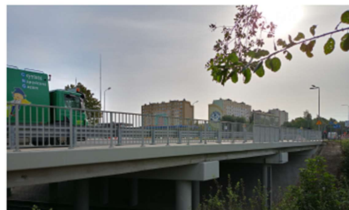
obiekt mostowy w ciągu ul. Władysława IV
