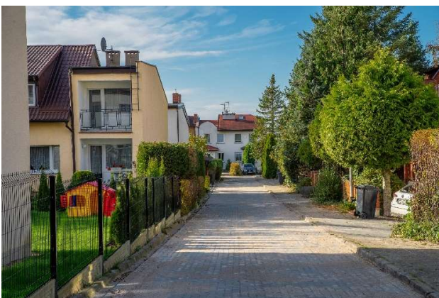
Modernizacja nawierzchni ul. Wesotej
