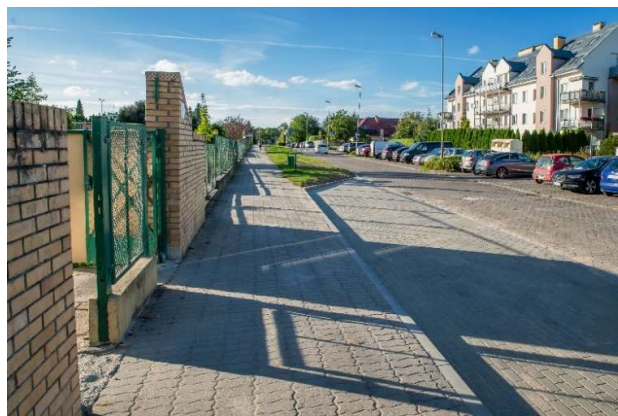
SCHOOL BUS 3 - Budowa zatoki postojowej przy Szkole Podstawowej nr 3 im. ks. Jana Twardowskiego w Koszalinie
