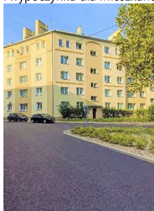
Modernizacja dróg ul. Hołdu Pruskiego
