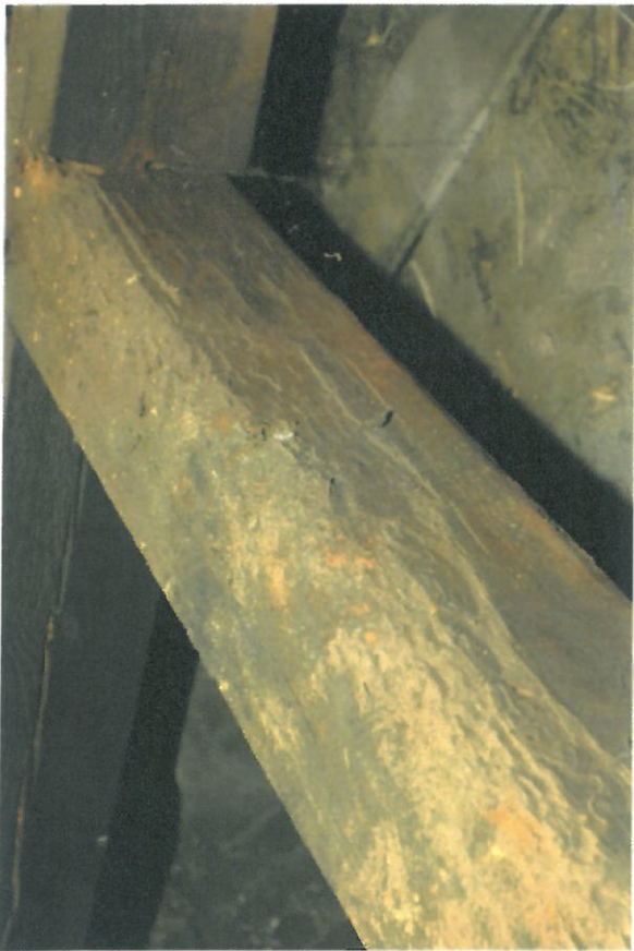
Fot.27 Belka rusztu zakwalifikowana do wymiany.
