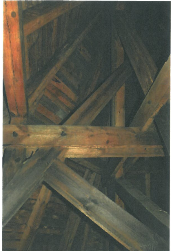
Fot. 20 Fragment konstrukcji więźby dachowej.
