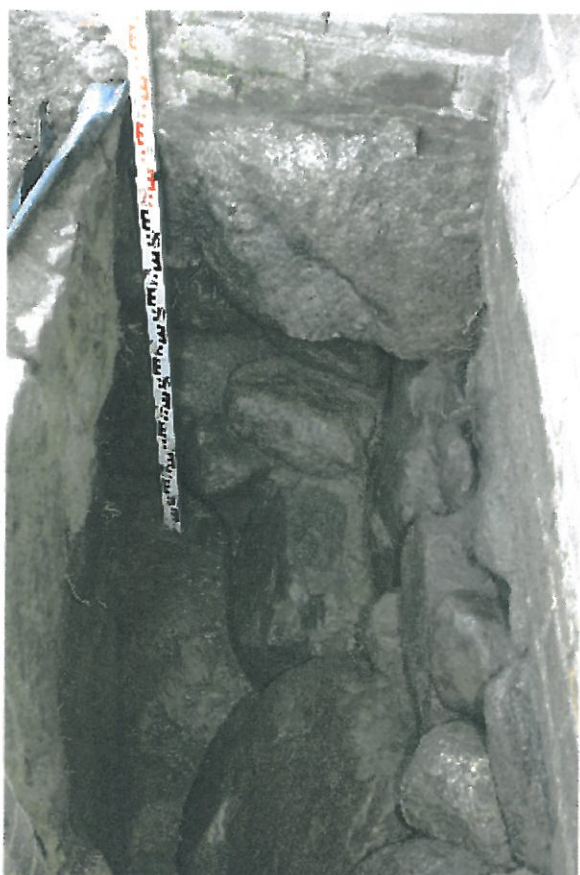
Fot. 32 Odkrywka ściany fundamentowej pod przyporą.
