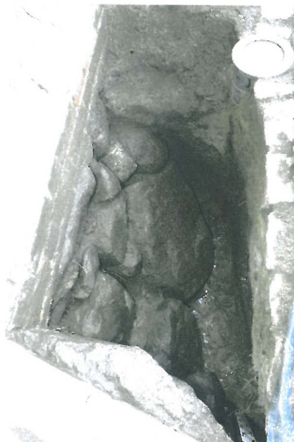
Fot. 30 Odkrywka ściany fundamentowej.
