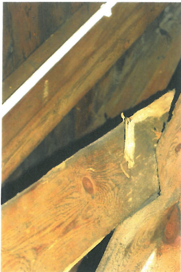
Fot. 29 Zastrzał zakwalifikowany do wymiany.
