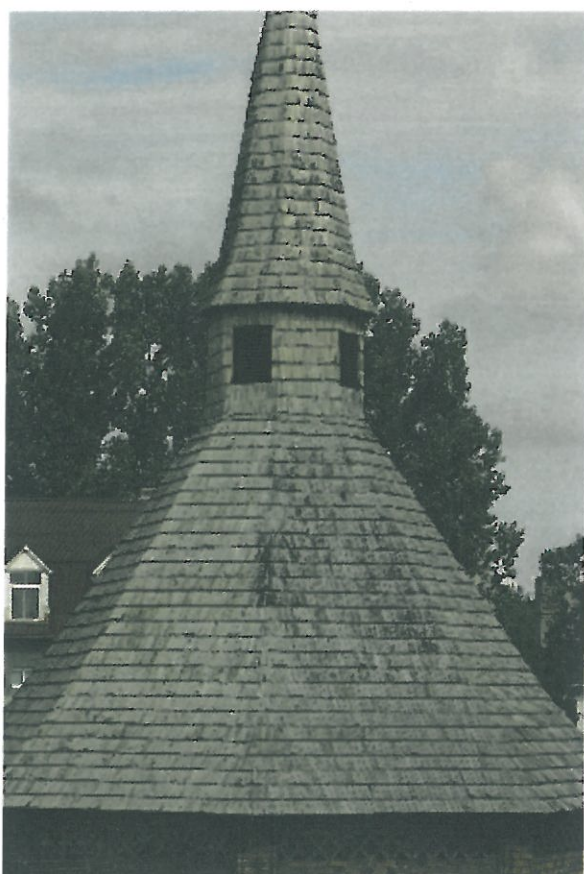
Fot. 3 Pokrycie dachowe gontem.
