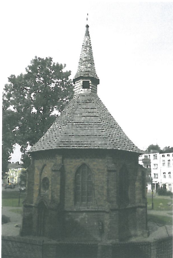
Fot. 1 Widok ogólny –elewacja płd-wsch.
