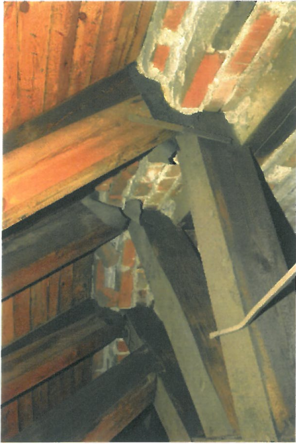
Fot. 17 Oparcie krokwi, rusztu na murłatach.
