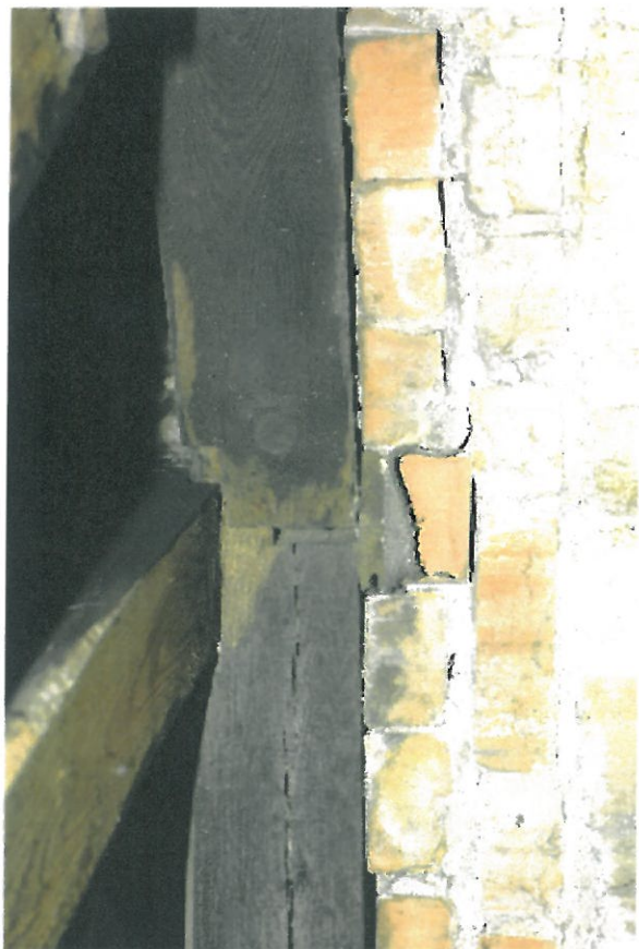
Fot. 15 Oparcie rusztu i murłat na ścianie
