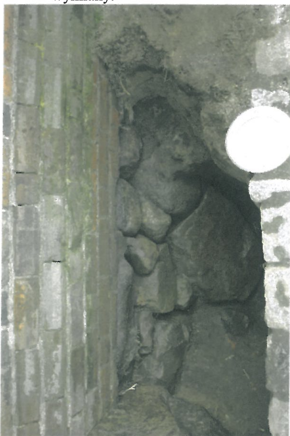
Fot. 31 Odkrywka ściany fundamentowej.
