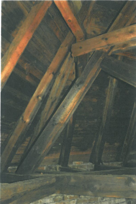
Fot. 19 Fragment konstrukcji więźby dachowej.
