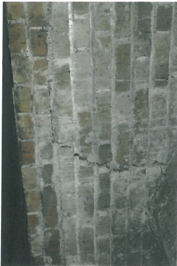
Fot. 13 Wewnętrzne lico ściany –nadproże.
