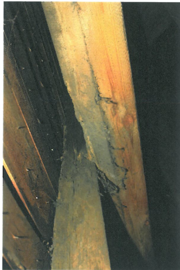
Fot.. 28 Płatew i krokiew zakwalifikowana do wymiany.
