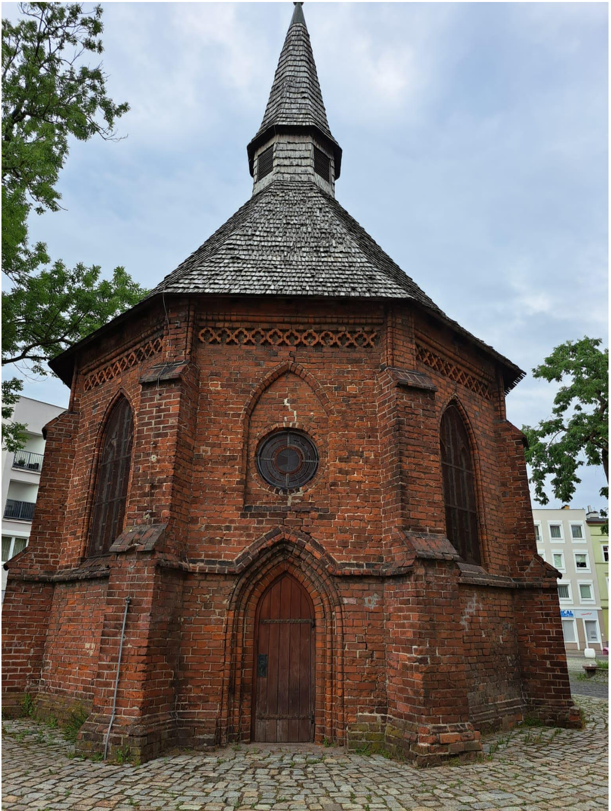
Zdjęcie nr 6 elewacja S-W
