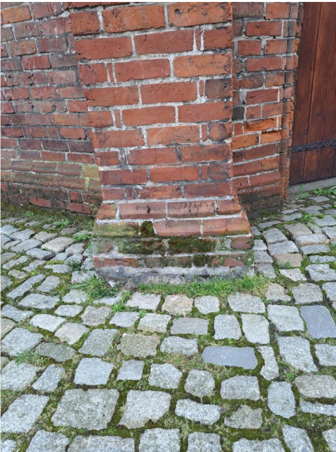
Zdjęcie nr 10 elewacja N – przypora fundament
