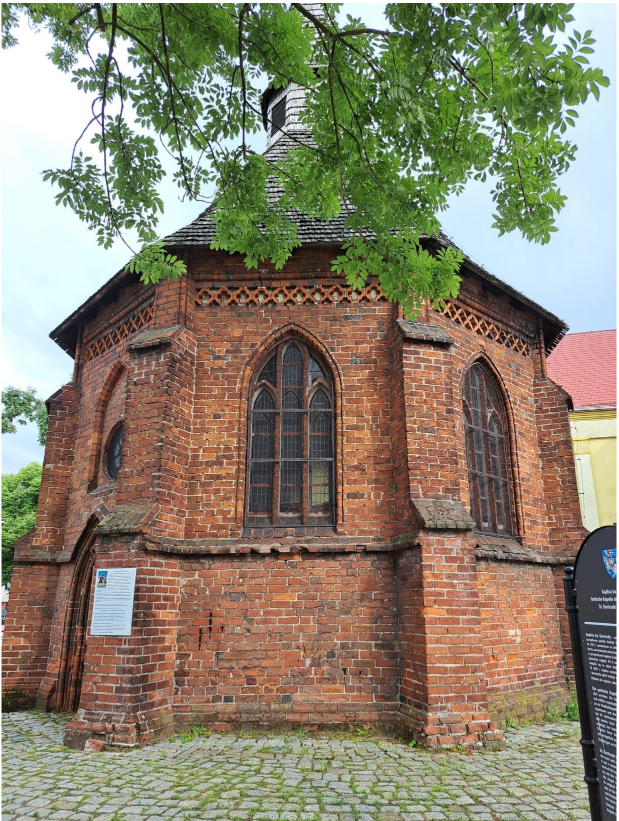
Zdjęcie nr 4 elewacja N-W
