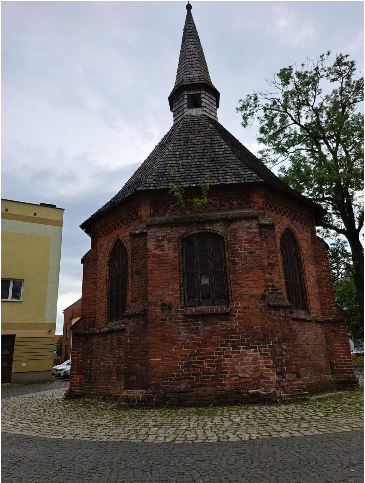
Zdjęcie nr 1 elewacja E
