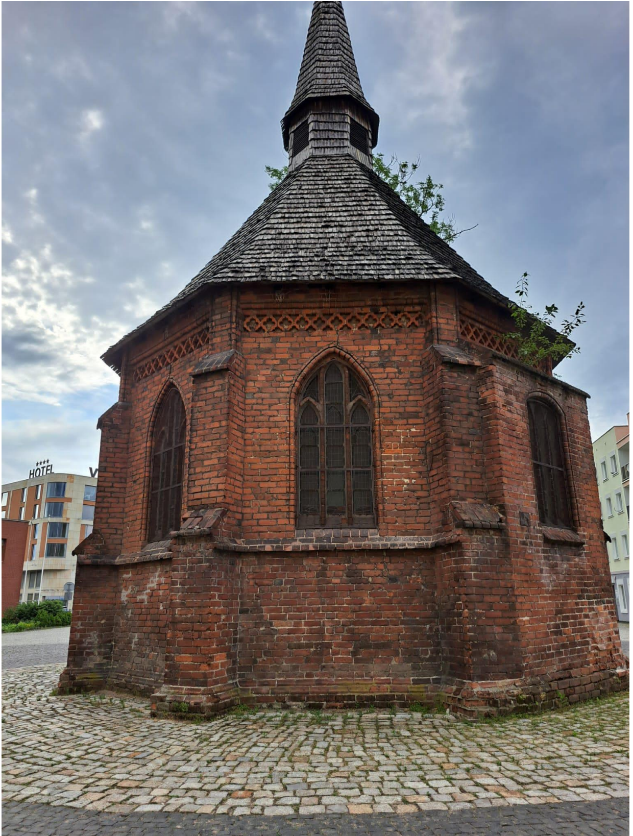
Zdjęcie nr 8 elewacja S-E
