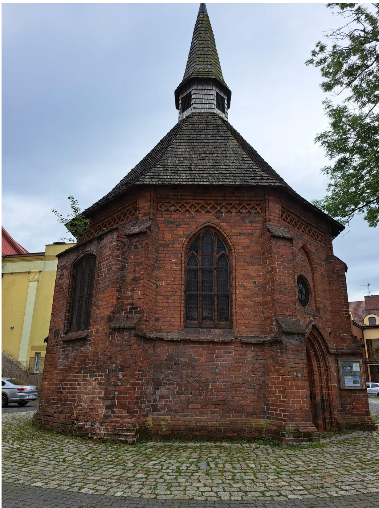
Zdjęcie nr 2 elewacja N-E
