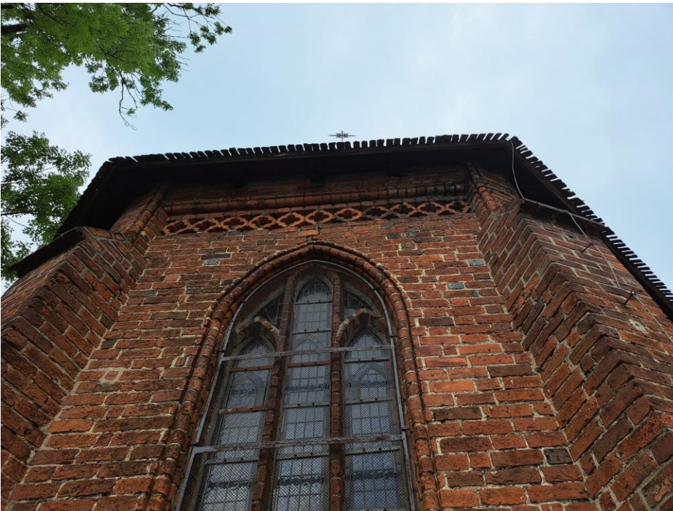
Zdjęcie nr 9 elewacja W - dach
