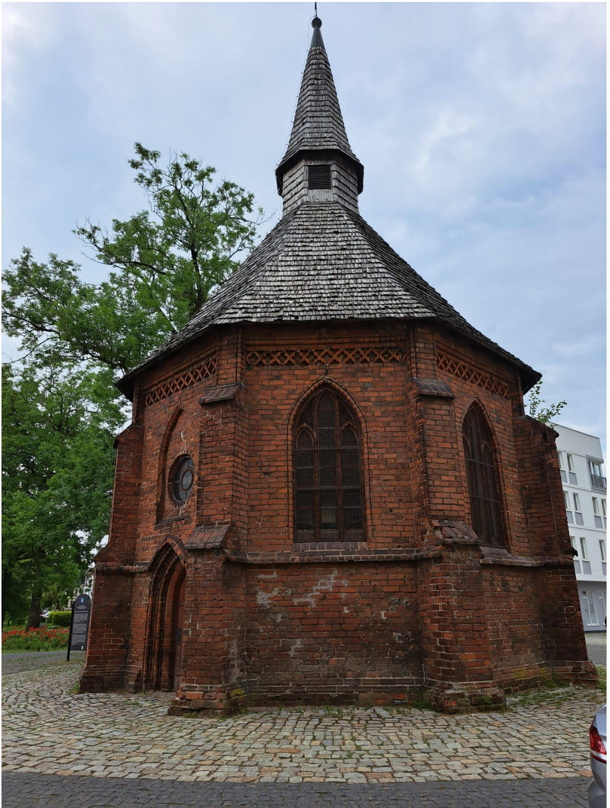
Zdjęcie nr 7 elewacja S
