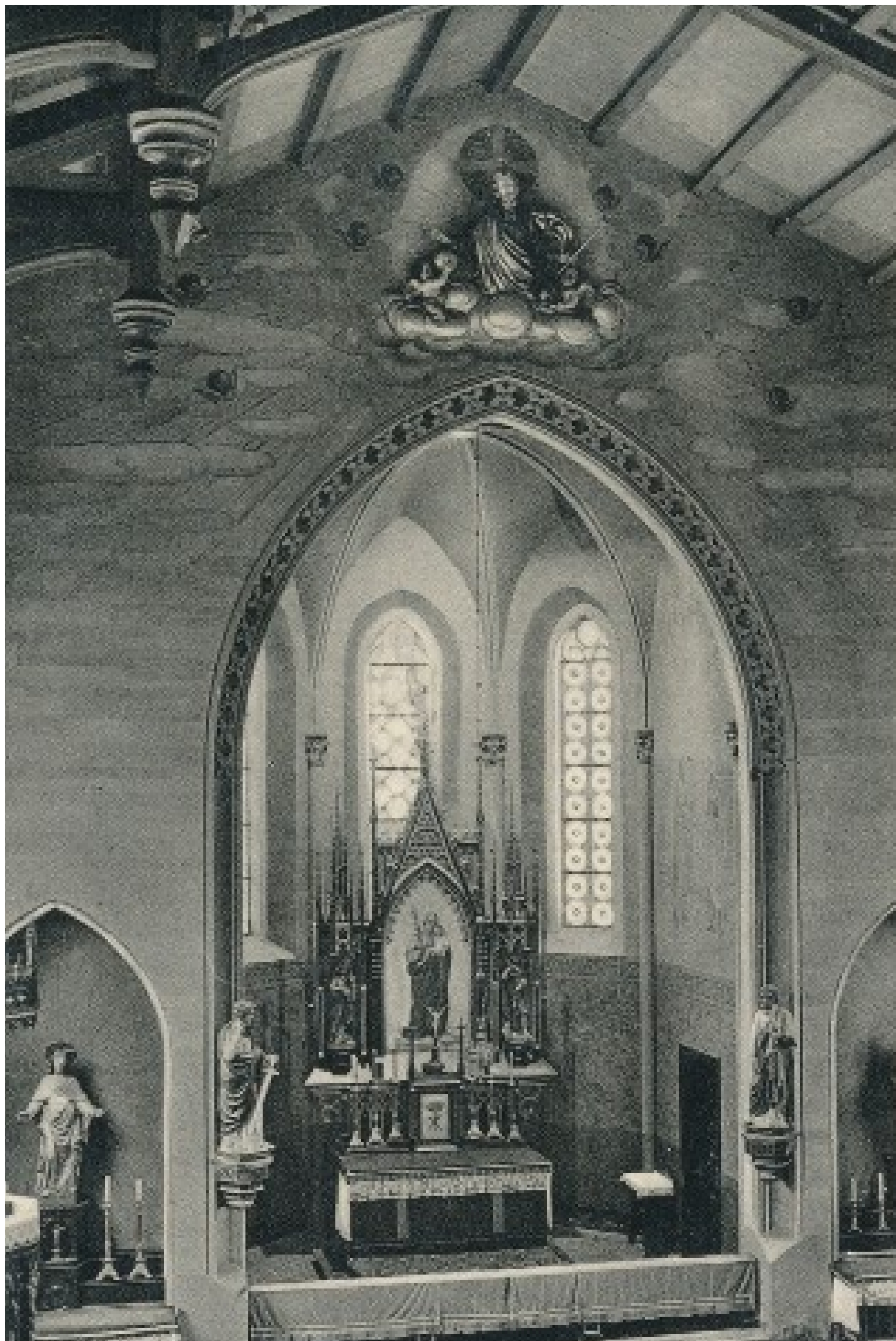
fot. 12. Koszalin, kościół pw. św. Józefa Oblubieńca NMP w Koszalinie, wnętrze. Domena publiczna. Ściana prezbiterium pokryta jest malowidłem z przedstawieniem nieba z aniołami. W prezbiterium, nad wejściem do zakrystii, widoczne jest malowidło figuralne. Pod przedstawieniem widoczny pas z napisem oraz ornamenty znajdujące się poniżej, tworząc lamperię. We wnękach za rzezbami widoczne są namalowane promienie. Po bokach łuku tęczowego zawieszono rzeźby Piotra i Pawła.
