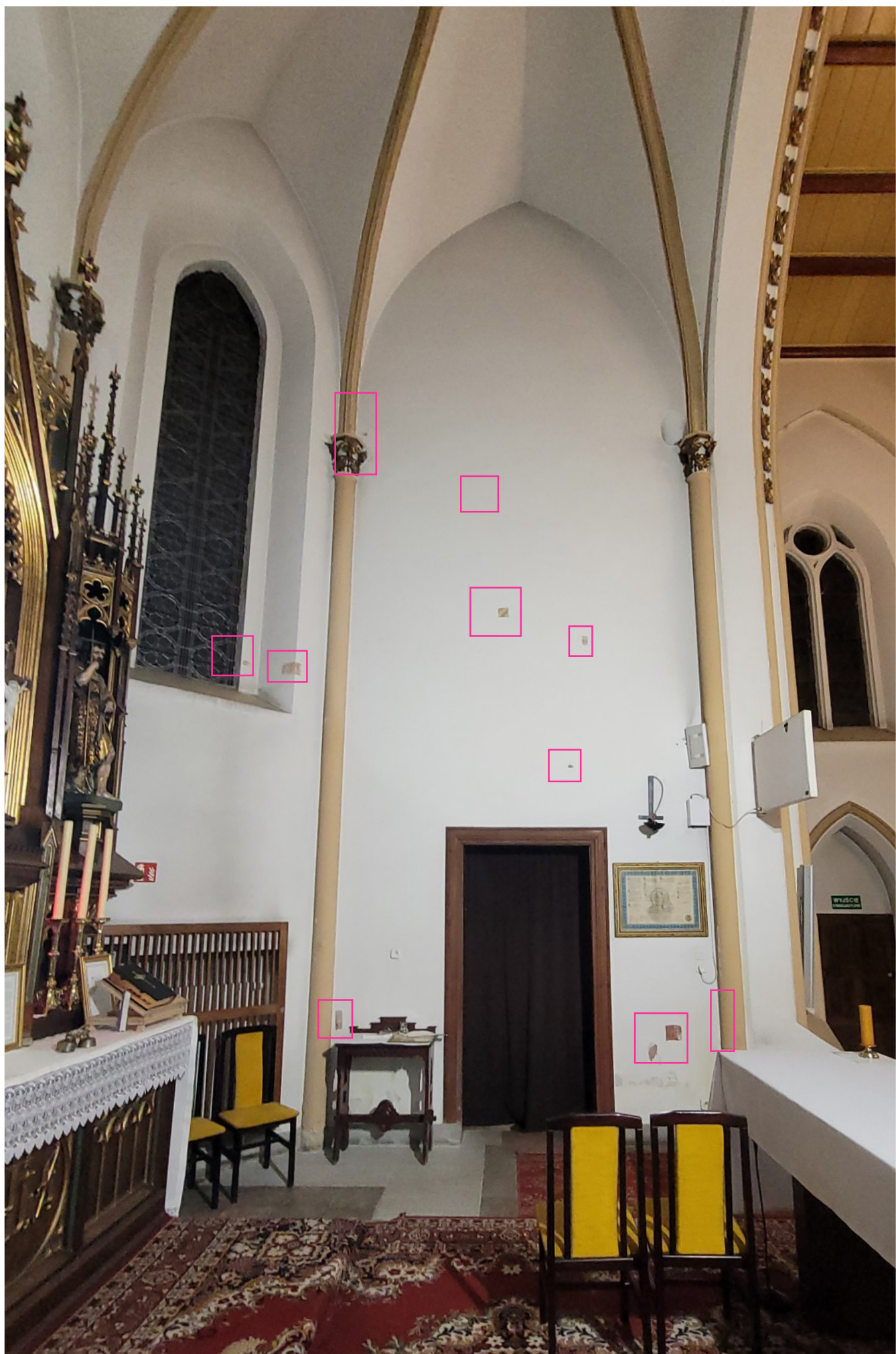
fot. 46. Kościół pw. św. Józefa Oblubieńca NMP w Koszalinie, prezbiterium, miejsca wykonanych odkrywek.
