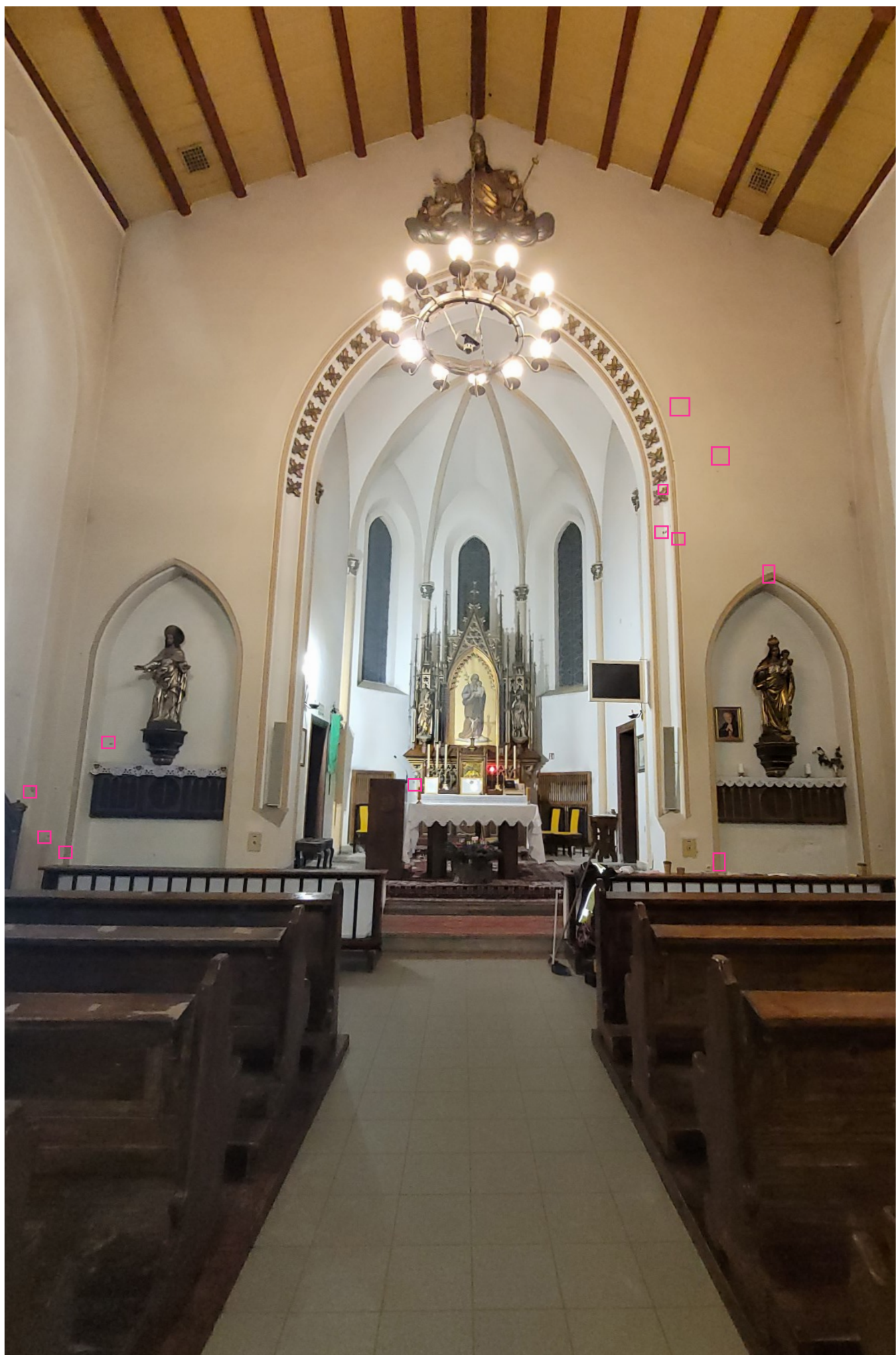
fot. 47. Kościół pw. św. Józefa Oblubieńca NMP w Koszalinie, Łuk tęczowy, miejsca wykonanych odkrywek.
