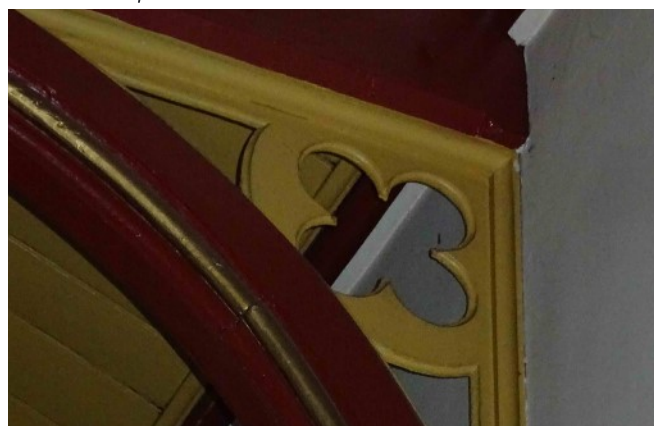
fot. 35. Kościół pw. św. Józefa Oblubieńca NMP w Koszalinie, dekoracyjne wypełnienie przestrzeni między kroksztynem a mieczem - w formie czwórliścia.
