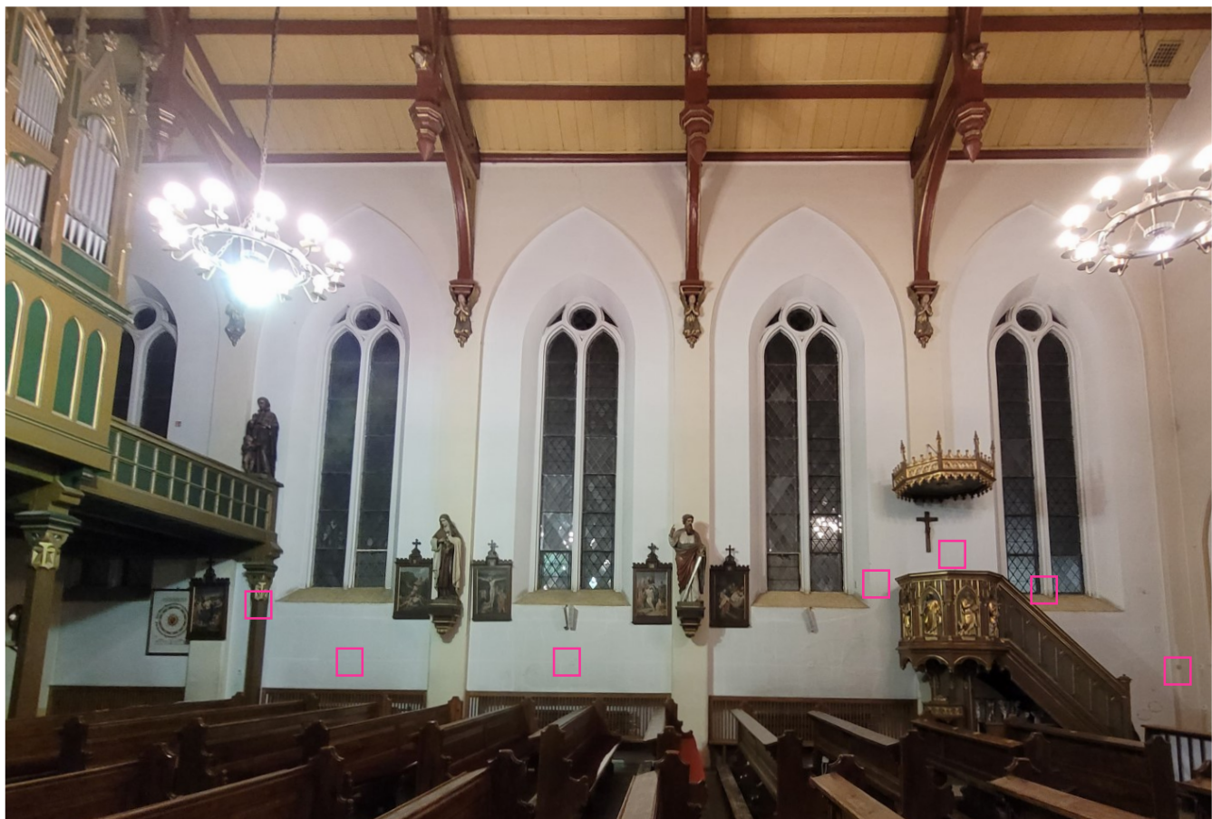
fot. 44. Kościół pw. św. Józefa Oblubieńca NMP w Koszalinie, wewnątrz kościoła, ściana południowa, miejsca wykonanych odkrywek.
