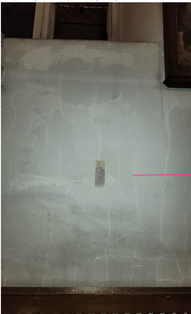
fot. 66. Kościół pw. św. Józefa Oblubieńca NMP w Koszalinie, odkrywka na ścianie nawy głównej.
