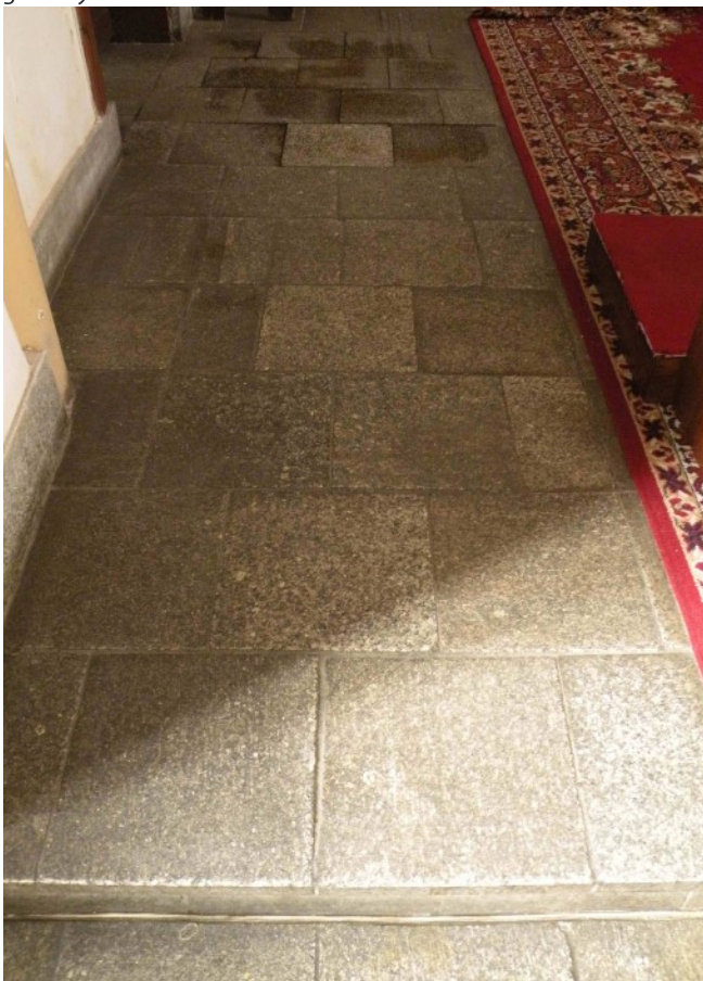
fot. 26. Kościół pw. św. Józefa Oblubieńca NMP w Koszalinie, posadzka z prezbiterium wykonana z płytek z granitu strzegomskiego.
