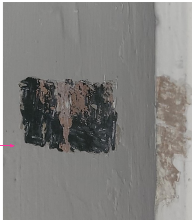
fot. 58. Kościół pw. św. Józefa Oblubieńca NMP w Koszalinie, widoczne ciemne kolory tła.
