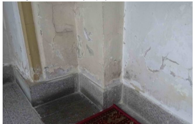
fot. 30. Kościół pw. św. Józefa Oblubieńca NMP w Koszalinie, zdeintegrowane tynki przyziemia.
