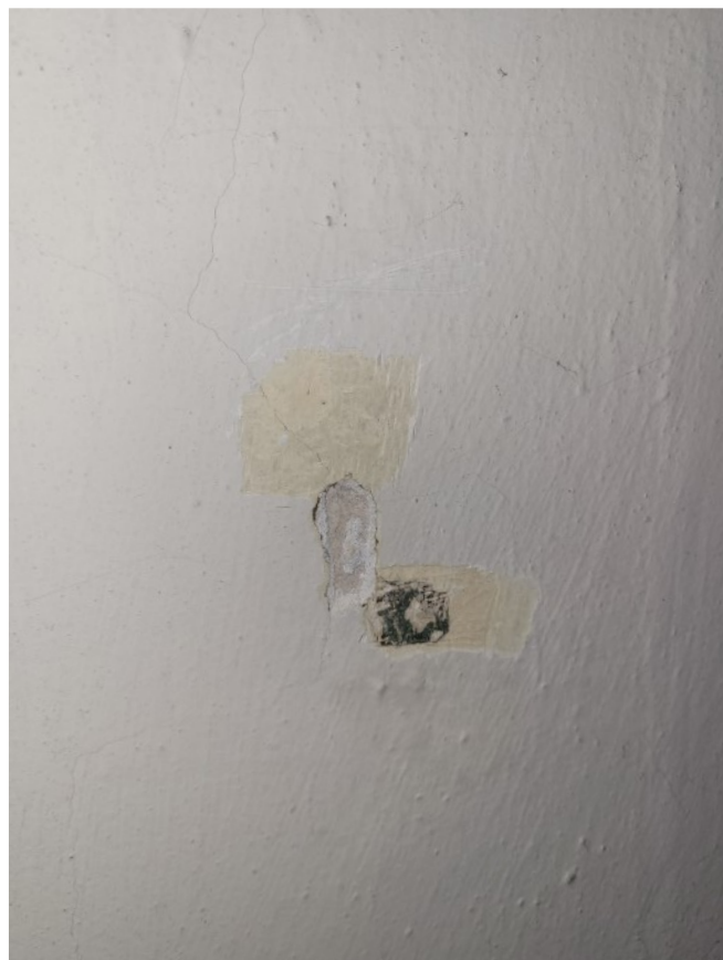
fot. 54. Kościół pw. św. Józefa Oblubieńca NMP w Koszalinie, wewnątrz kościoła, ściana południowa, stan na 2020 rok.
