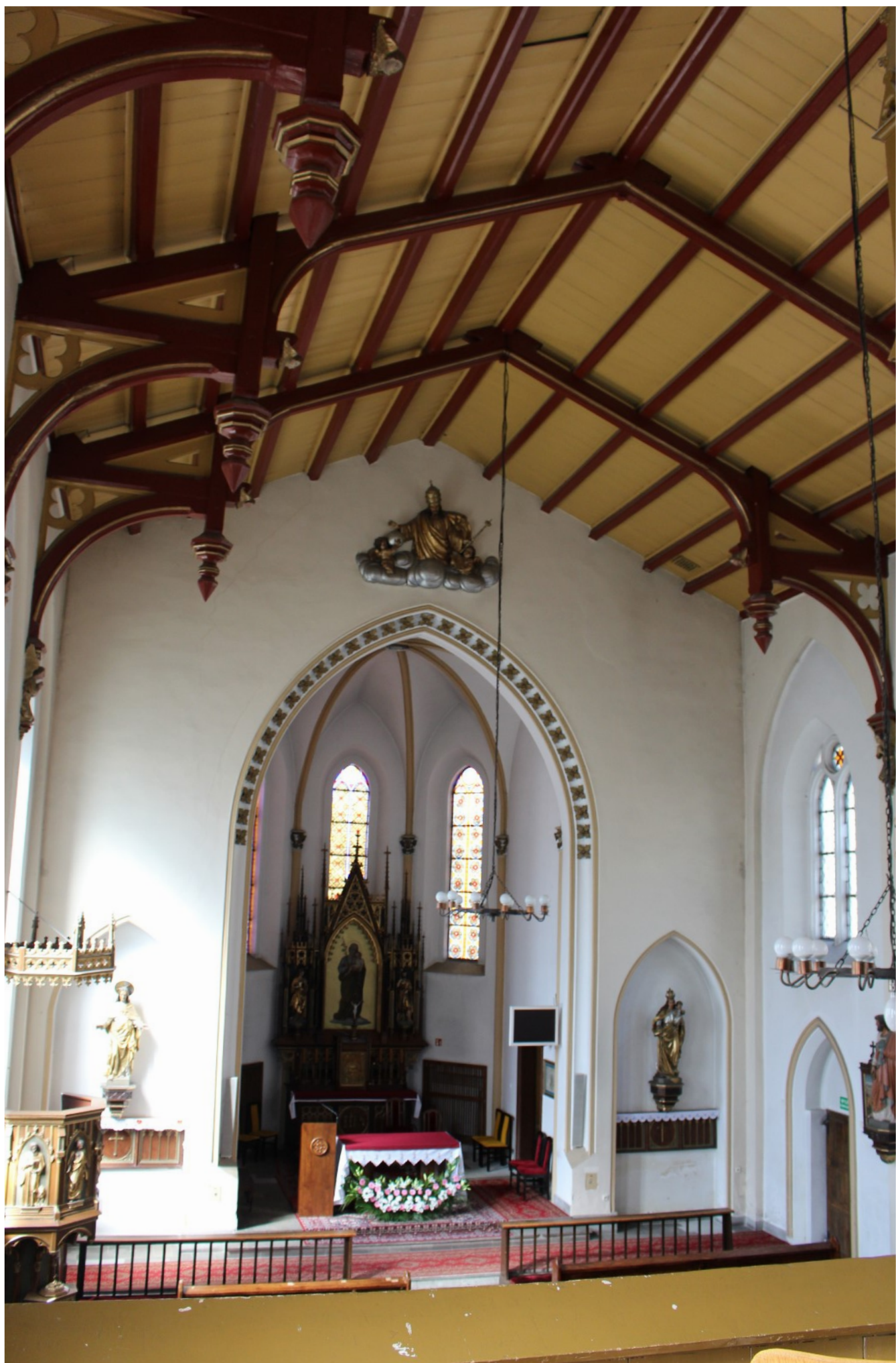
fol. 14. Kościół pw. św. Józefa Oblubieńca NMP w Koszalinie, wnętrze kościoła, ściana zachodnia, widok na prezbiterium.
