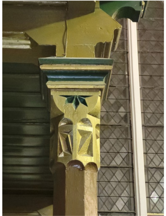
fot. 42. Kościół pw. św. Józefa Oblubieńca NMP w Koszalinie, wewnątrz kościoła, filar empory muzycznej.
