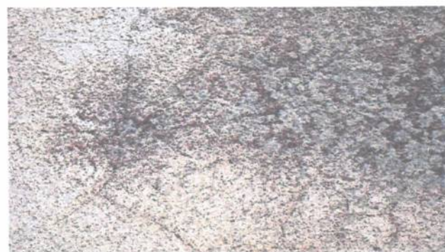
Nie wykonano dylatacji pomiędzy ścianą attyki a płytami DKZ . Powstały zarysowania i spękania. Odparzony tynk z powodu przeciekania rynny.
