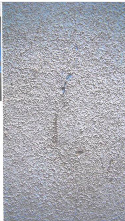
Nie wykonano dylatacji pomiędzy ścianą attyki a płytami DKZ . Powstały zarysowania i spękania. Odparzony tynk z powodu przeciekania rynny.
