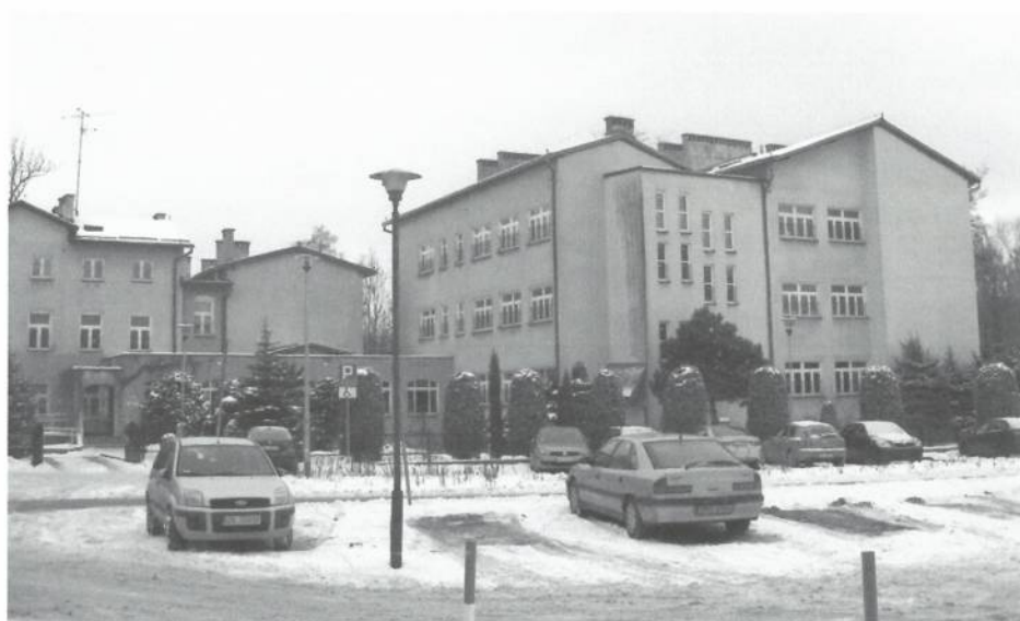
Fot. 3.1. Ogólny widok budynku A (segment dydaktyczny) od strony ul. Rzecznej
