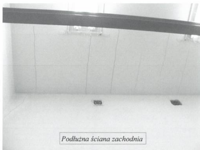
Fot. 3.14. Niezbyt rozległe o małej szerokości rozwarcia zarysowania stropu nad salą korekcyjną oraz ścian i stropu nad piętrem budynku w obszarze wejścia do pomieszczenia nr 18
