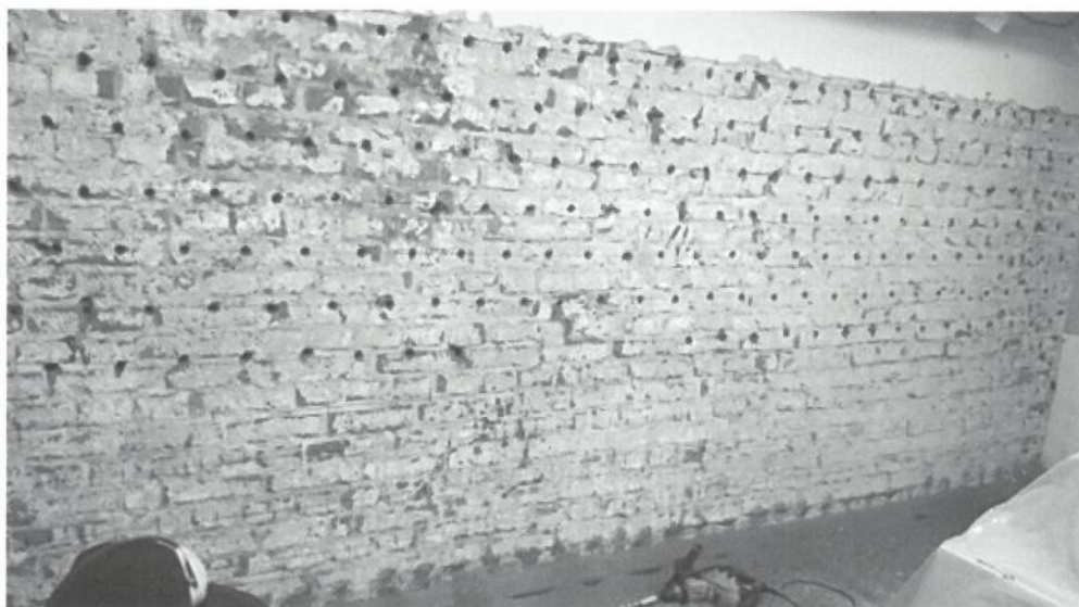
Fot. 5.5. Przykład kurtynowej Iniekcji Krystalicznej ®
