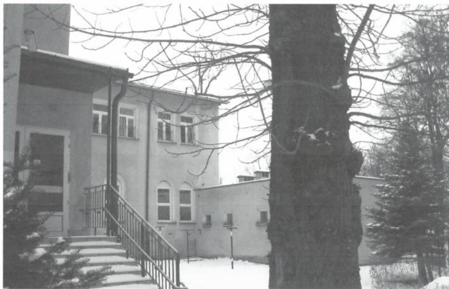
Fot. 3.7. Ogólny widok od strony południowo-wschodniej dwukondygnacyjnego budynku sali sportowej oraz parterowego pawilonu pralni (segment „D”)
