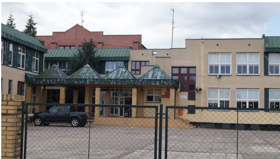
1. Zadaszenie wejścia głównego do budynku szkoły z dachami namiotowymi w układzie szeregowym.
