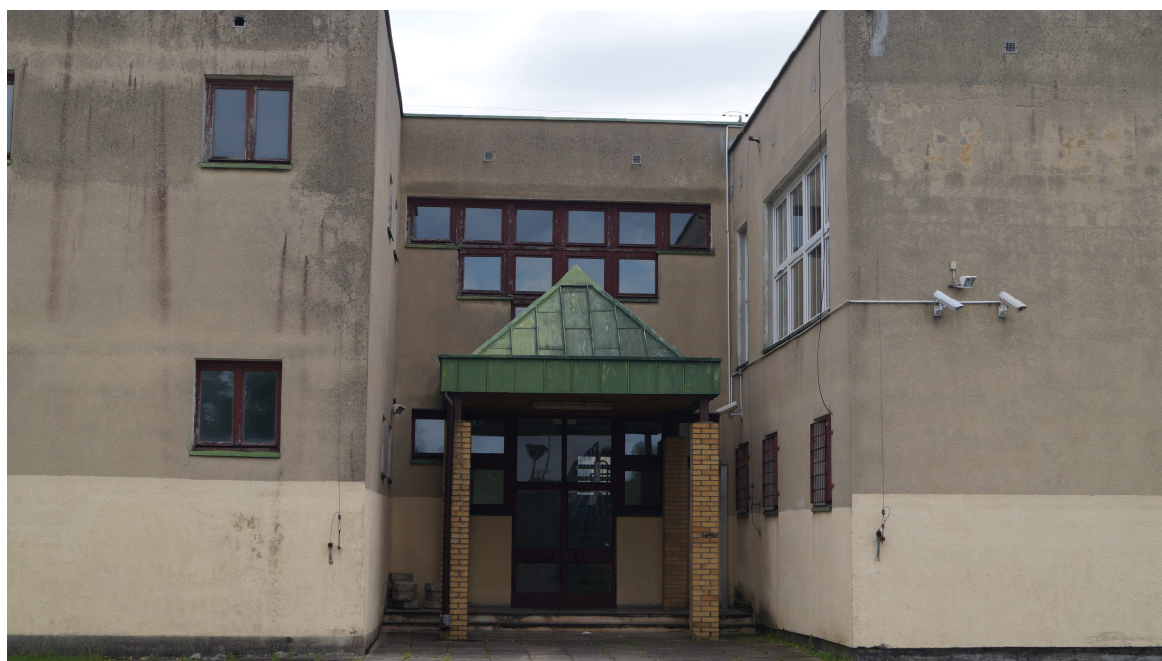
2. Zadaszenie wejścia do łącznika sali gimnastycznej z pojedynczym dachem namiotowym.
